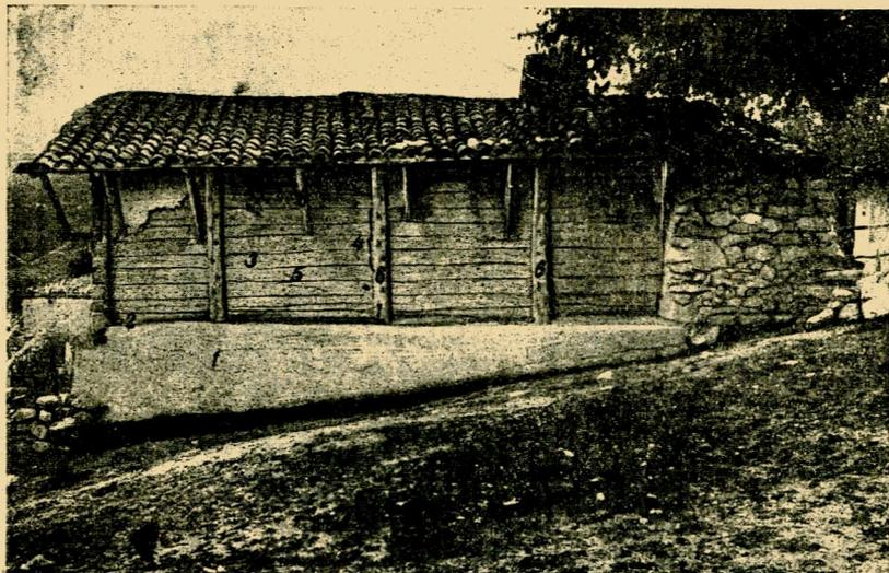
Рис. 9. Стена с деталями постройки; скрепления плах: 1) каменный фундамент, 2) продольные бревна, 3) стены, 4) сруб, 5) колышек, гвоздь, 6) упоры, 7) черепица, 8) упоры (Дом Бекир-Умерова, дер. Юкары-Каралез.)
