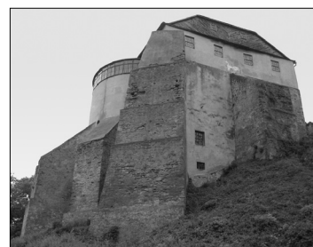
Острозький замок. Вежа мурована. Вигляд з південного сходу. Фото 2008.
