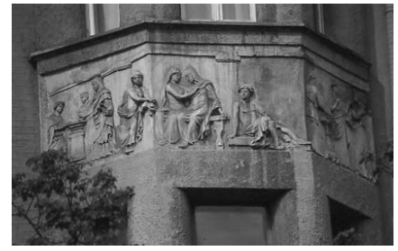
486.3. Фрагмент оздоблення еркера.
