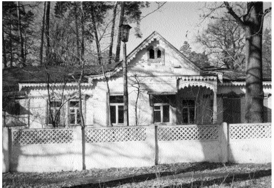
460.7. Вул. М. Юнкерова, 43.
