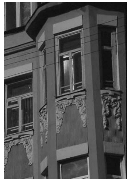
486.52. Фрагмент оздоблення еркера.
