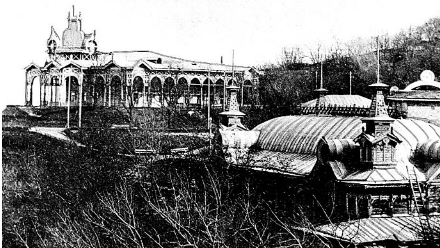
427. Фрагмент забудови. Фото 1906.
