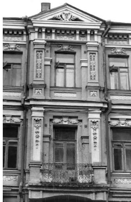
266.17. Вул. Михайлівська, 7. Фрагмент головного фасаду.
