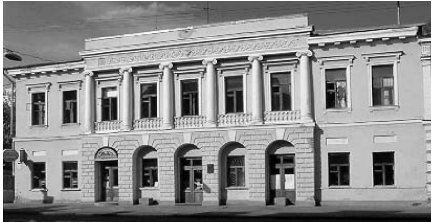
468.9. Вул. П. Сагайдачного, 20/2. Фрагмент фасаду.
