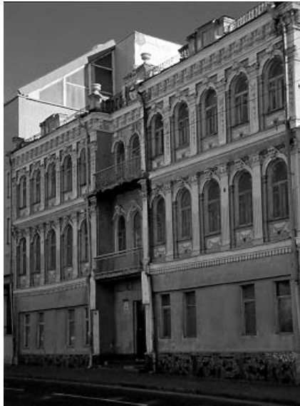
468.4. Вул. П. Сагайдачного, 19.
