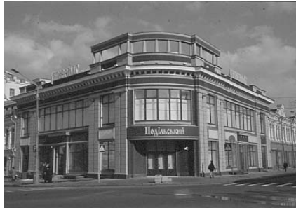
468.11. Вул. П. Сагайдачного, 24.
