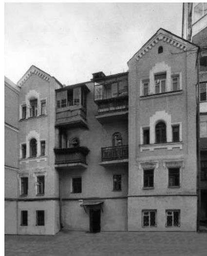
249.13. Вул. Мала Житомирська, 20-б.
