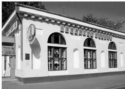
468.10. Вул. П. Сагайдачного, 16/5.
