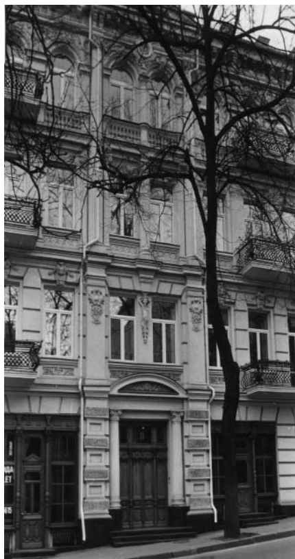
266.2. Вул. Михайлівська, 11. Фрагмент головного фасаду.
