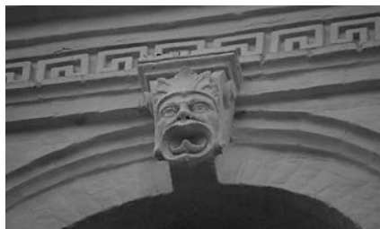
486.18. Вінцевий фронтон. 486.18. Замковий камінь архівольта.
