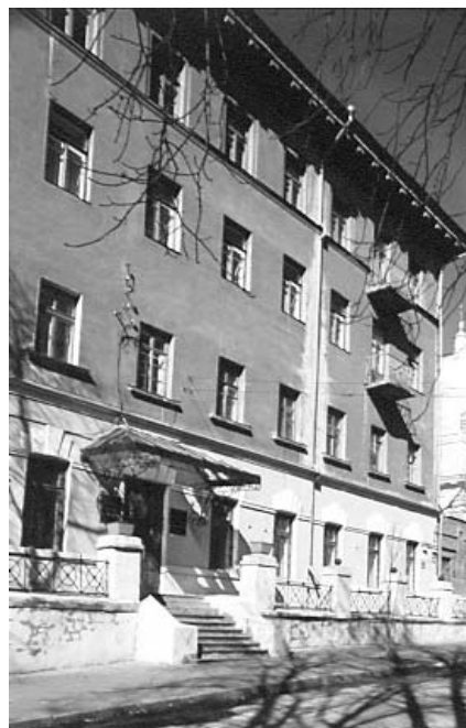
303.2. Будинок домініканського монастиря.
