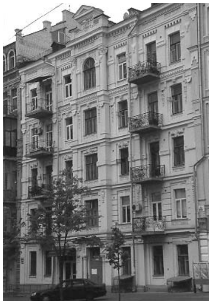
467.4. Вул. Ш. Руставелі, 36.
