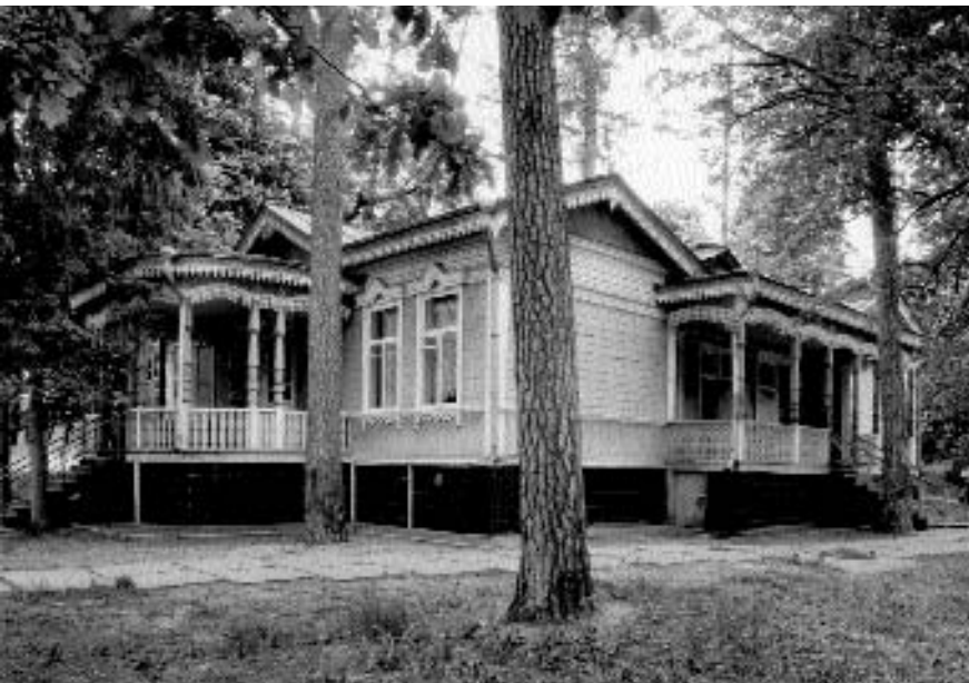
460.8. Вул. М. Юнкерова, 47.
