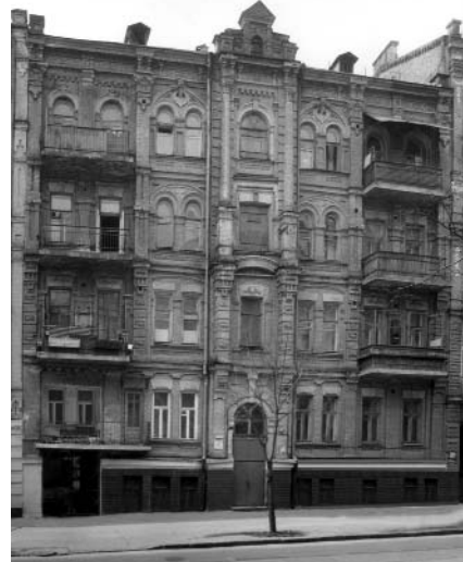
467.1. Вул. Ш. Руставелі, 32.
