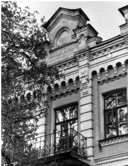
301.4. Фрагмент головного фасаду.
