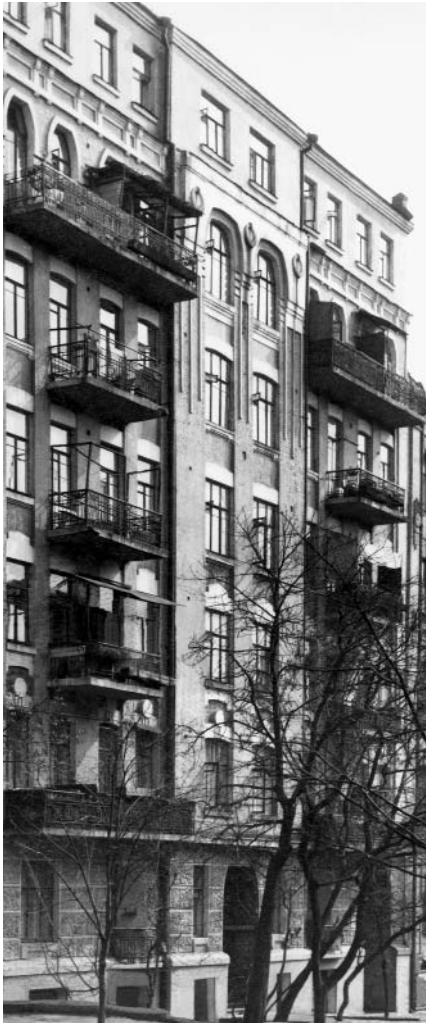
467.13. Вул. Ш. Руставелі, 27.
