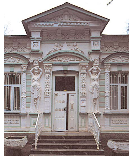
490.3. Фрагмент оформлення входу.
