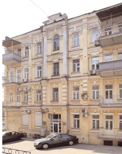
561.54. Вул. Червоноармійська, 38-б.
