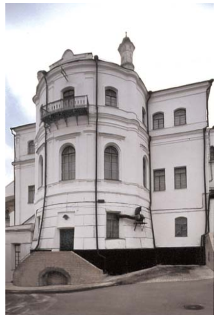
489.1.14. Фрагмент східного фасаду.
