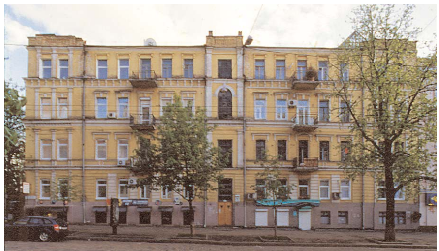
541.11. Вул. Б. Хмельницького, 29/2.
