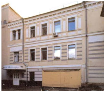
541.34. Вул. Б. Хмельницького, 34.
