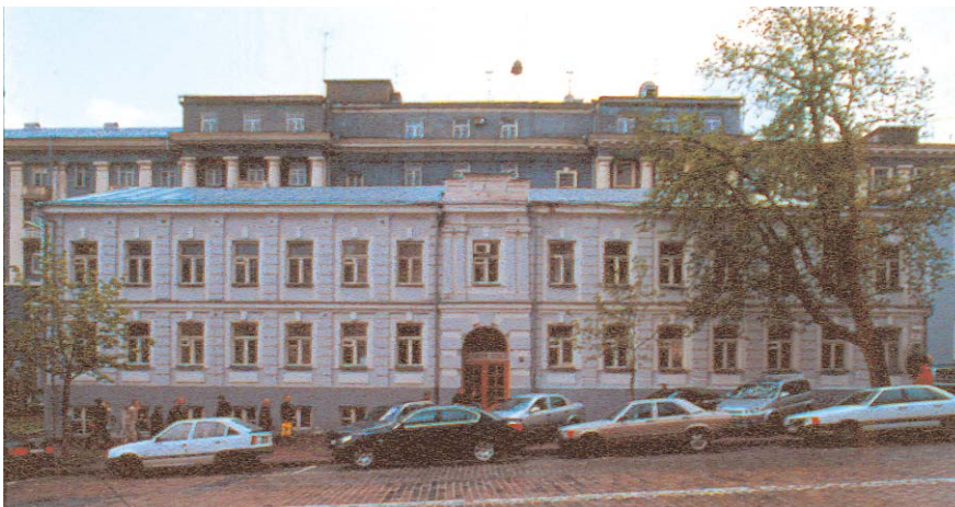
541.24. Вул. Б. Хмельницького, 9-а.
