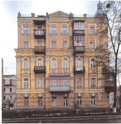
521.10. Вул. Л. Толстого, 19/1.
