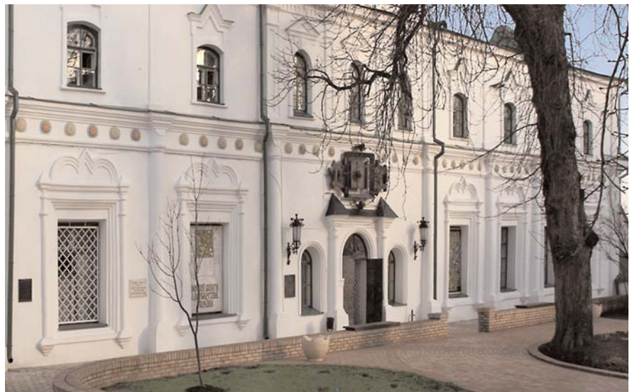
489.1.14. Фрагмент західного фасаду.
