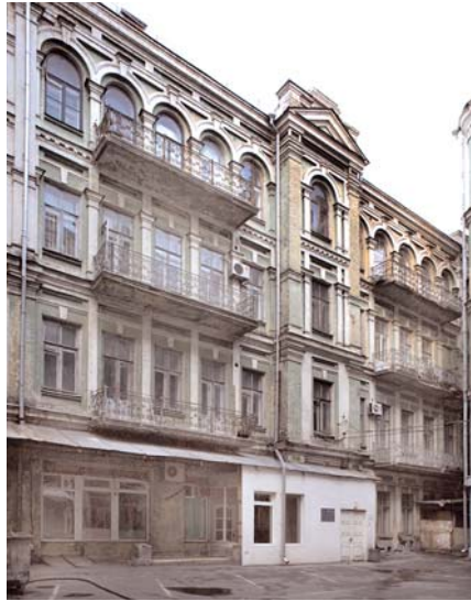
541.28. Вул. Б. Хмельницького, 26-а.
