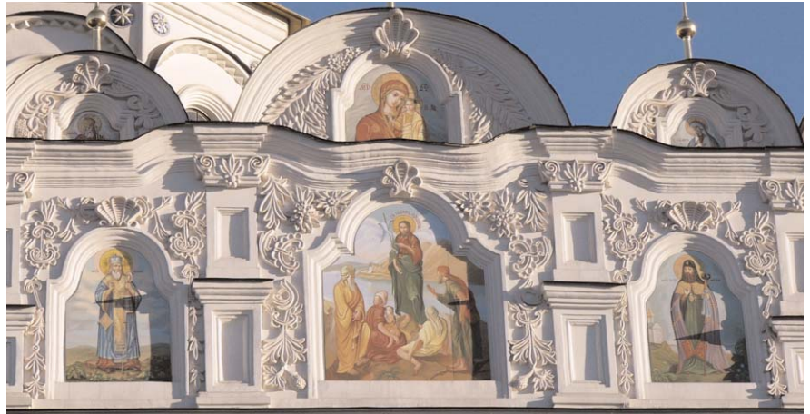
489.1.1. Фронтон північного фасаду. В центрі ікона «Проповідь Іоанна Предтечі».
