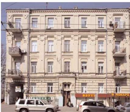
561.53. Вул. Шота Руставелі, 24.
