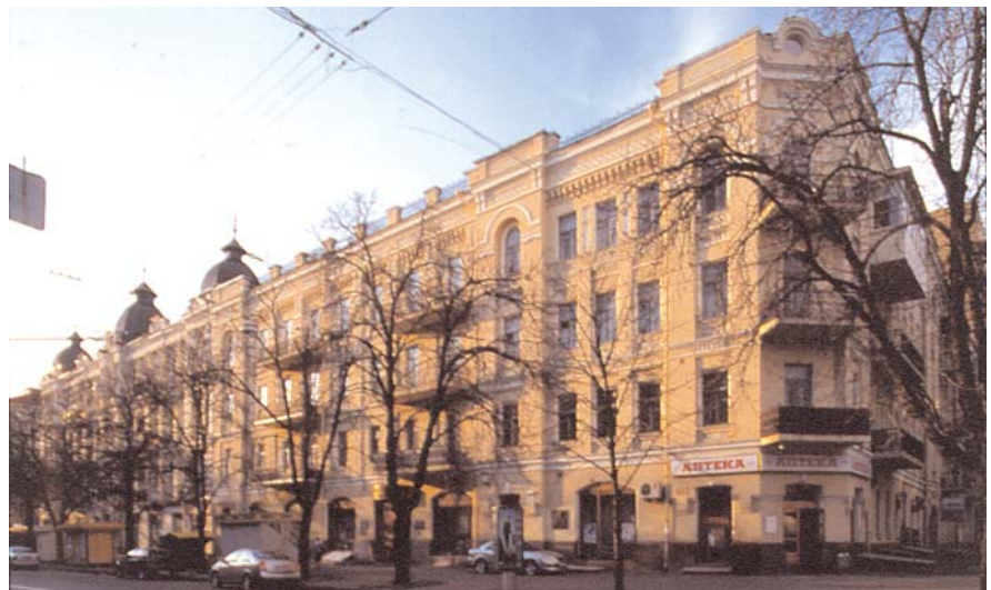
541.17. Вул. Б. Хмельницького, 42/32.
