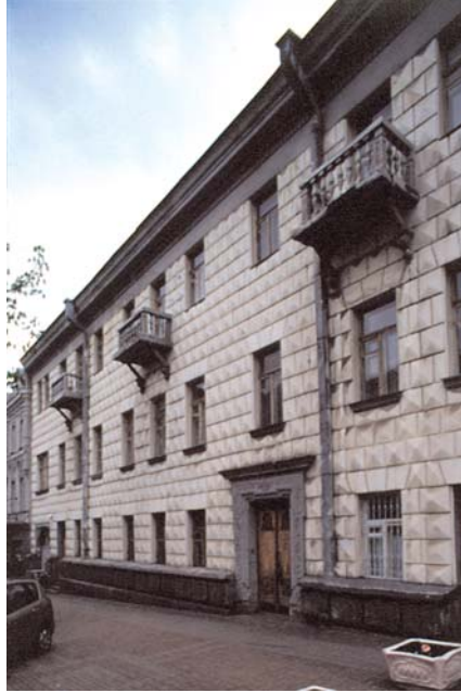
541.33.1. Вул. Б. Хмельницького, 5.
