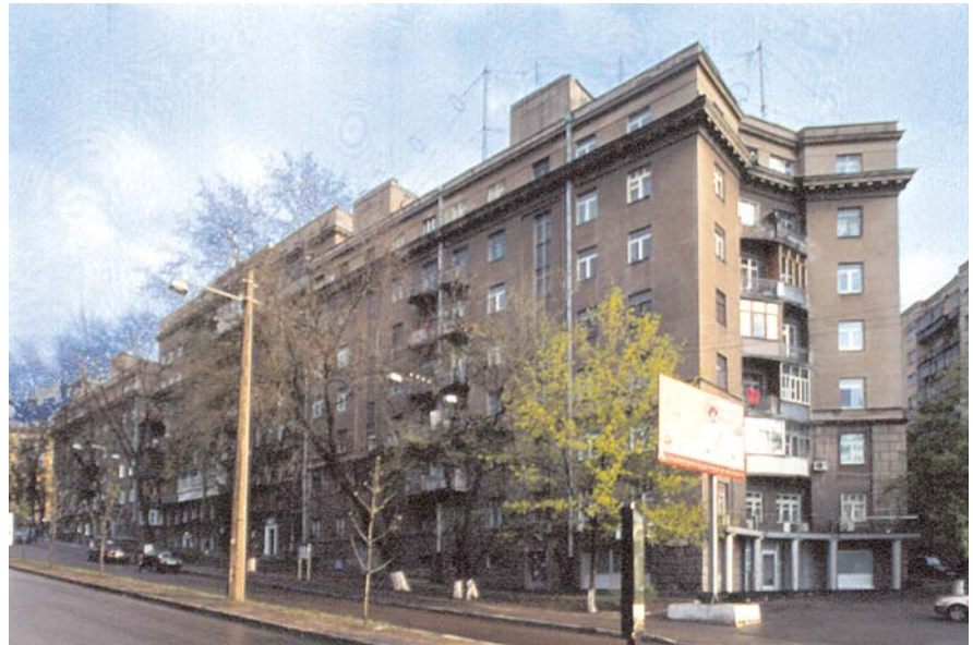
521.13. Вул. Л. Толстого, 25/2—25/18.
