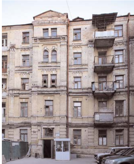
561.50. Вул. Червоноармійська, 17-б.
