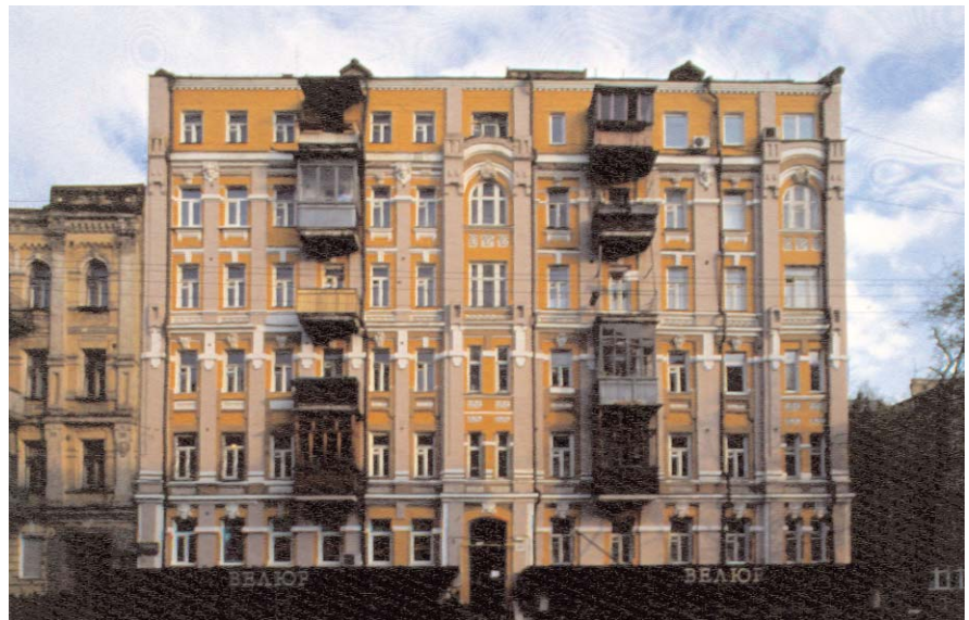
521.6. Вул. Л. Толстого, 43.
