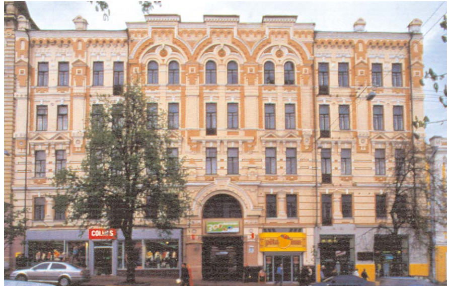
541.29. Вул. Б. Хмельницького, 10.
