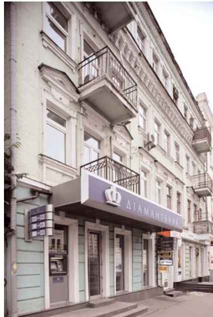
521.2. Вул. Л. Толстого, 8.
