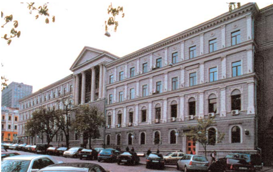
541.35. Вул. Б. Хмельницького, 6.
