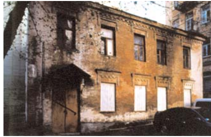
541.31. Вул. Б. Хмельницького, 59-а.
