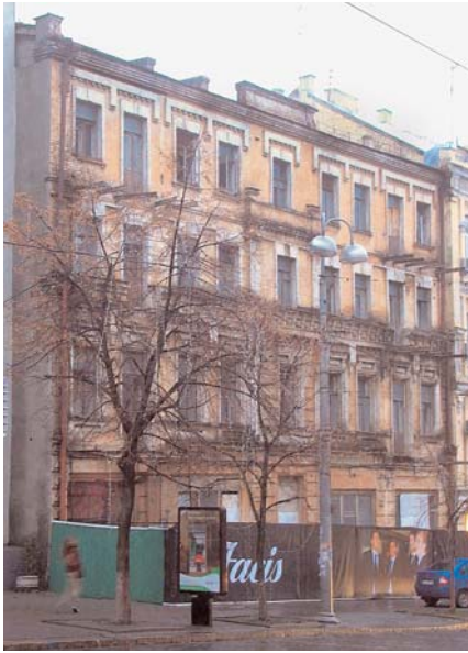
561.13. Вул. Червоноармійська, 39-б.
