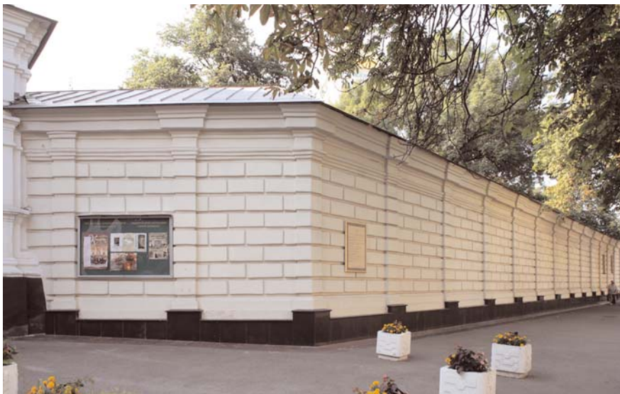
503.11. Фасад пристінного корпусу.
