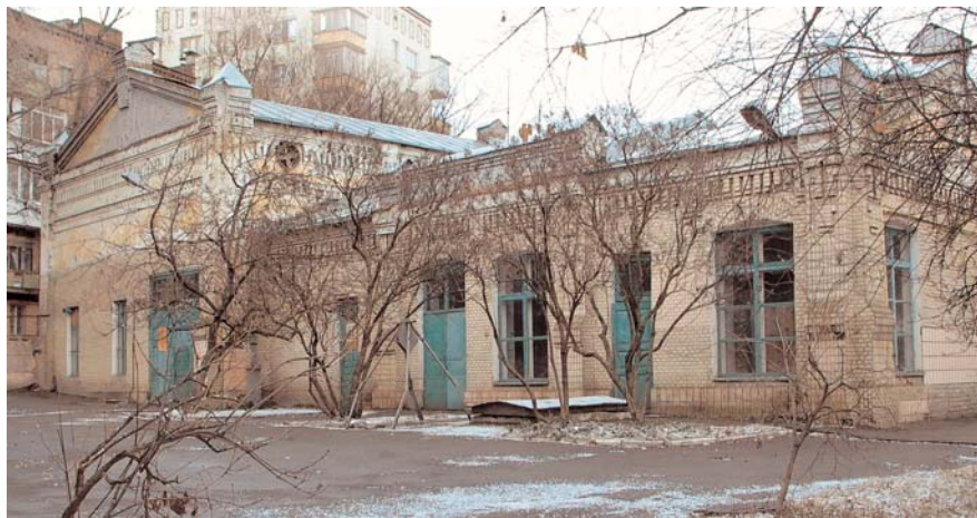
510. Станція водогінна насосна.
