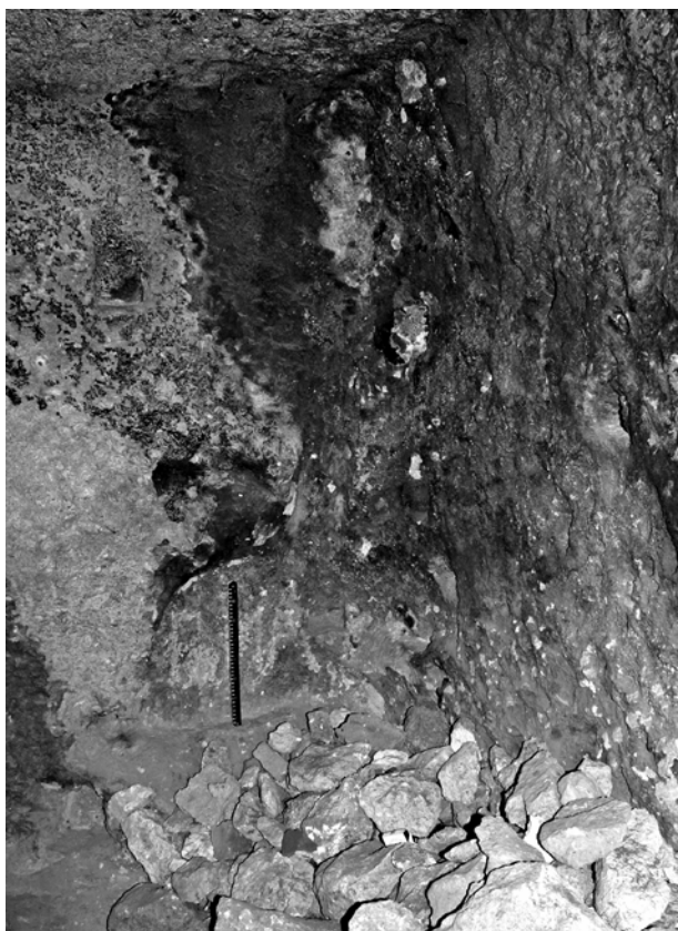
Фото 16. Северо-западный угол помещения №2
