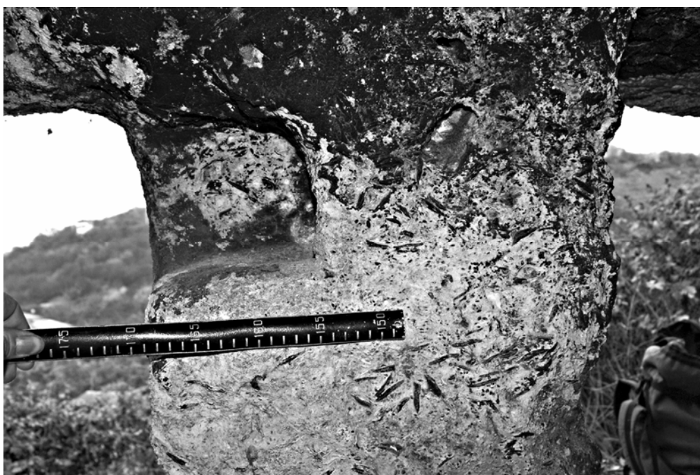
Фото 29. Подрубка в дверном проёме помещения №2
