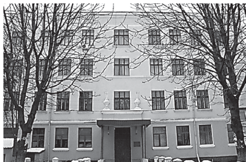
Приміщення, в якому діє Галицький коледж.
