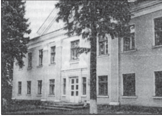
Приміщення селищної поліклініки.
