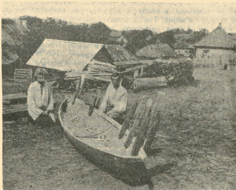
Мал. 3. Нашивка човна — прибивають дошку до борта човна, щоб зробити його глибшим.
