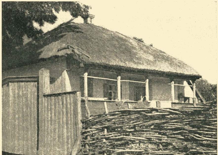
83. Защищённый низ галереи. Село Опошня. Полтавщина.
