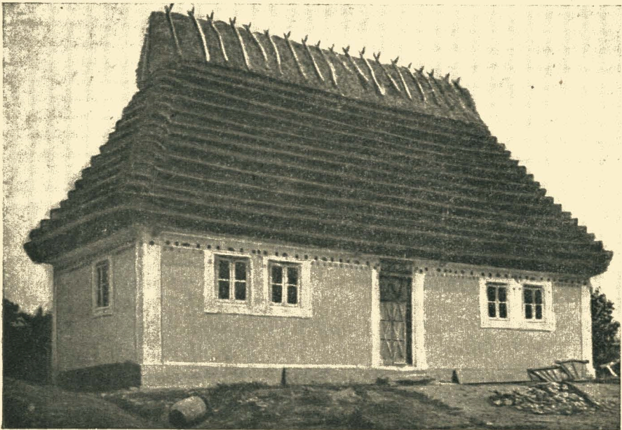
14. Хата с уступчатой крышей и пилястрами. Село Кадиивка. Подольщина (по К. Мощенко).
