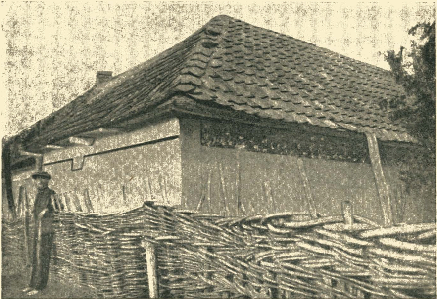
10. Черепичная кровля. Село Капуливка. Днепропетровщина (по Берченко).
