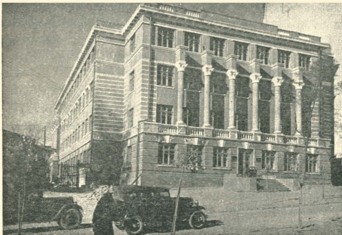
Нове шкільне будівництво в Києві. Школа на вул. Короленка. Фото С. Г. Шиманського
