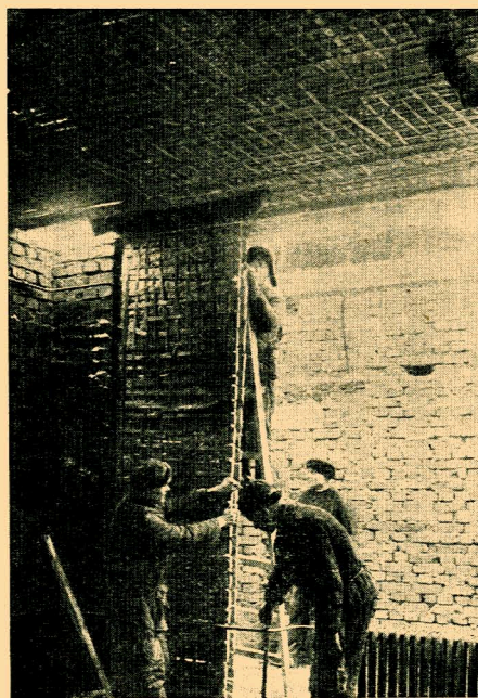
Photo 4. Mise en place de muret.
