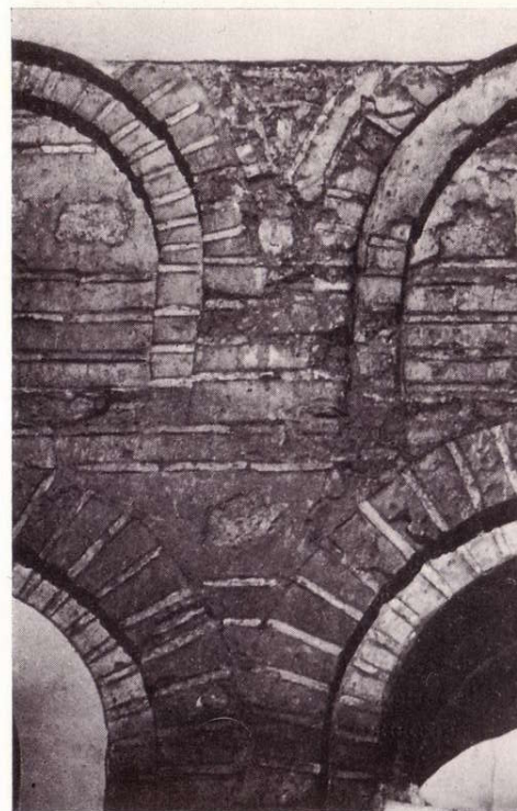
Деталь южного фасада.
