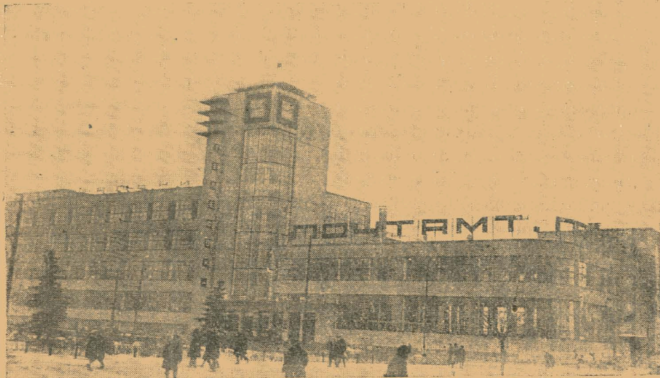
Новий будинок Центрального поштамту в м. Харкові.
