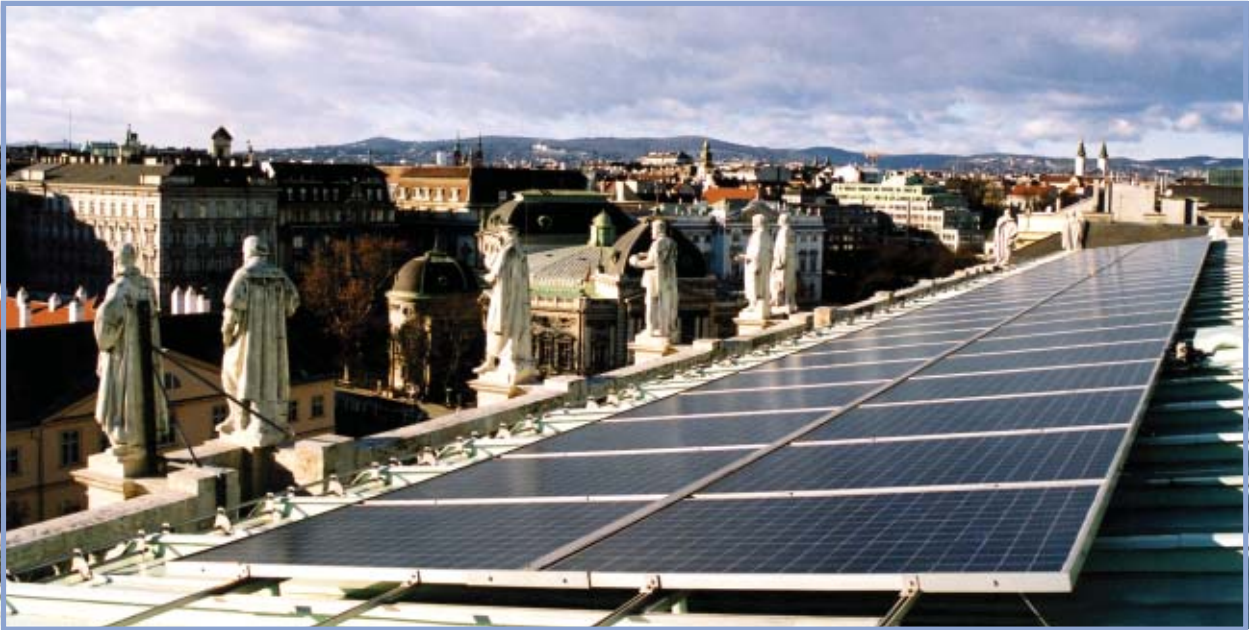
Фотоелектричні батареї на даху Музею історії в м. Відень (Австрія)
