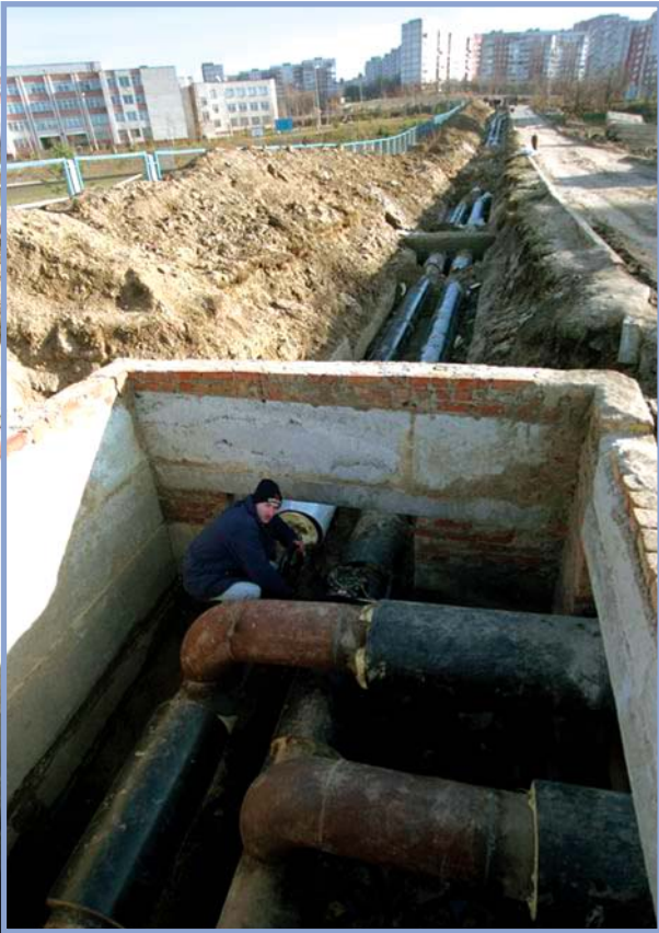
...до теплоізоляції трубопроводу. (м. Рівне)
