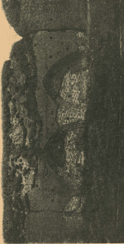
Часть стѣны съ внутренней стороны.
