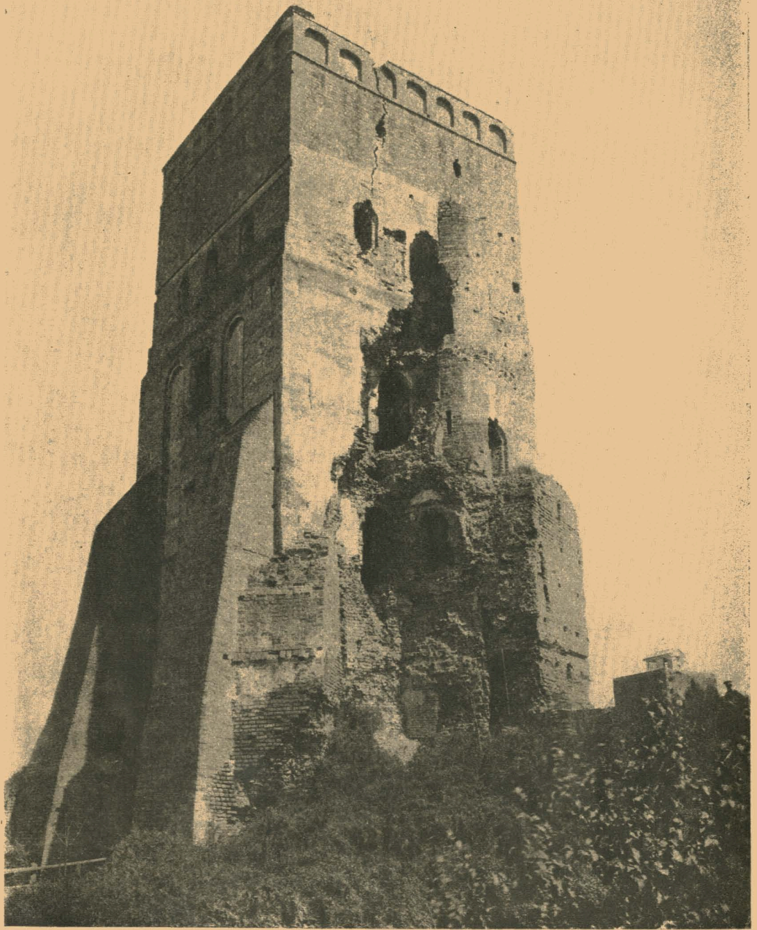
Большой замокъ. Башня съ вѣздными воротами.
