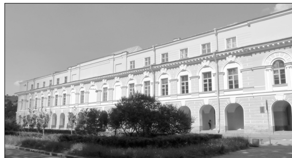
Будинок історичного факультету Санкт-Петербурзького університету. Фото 2011.
