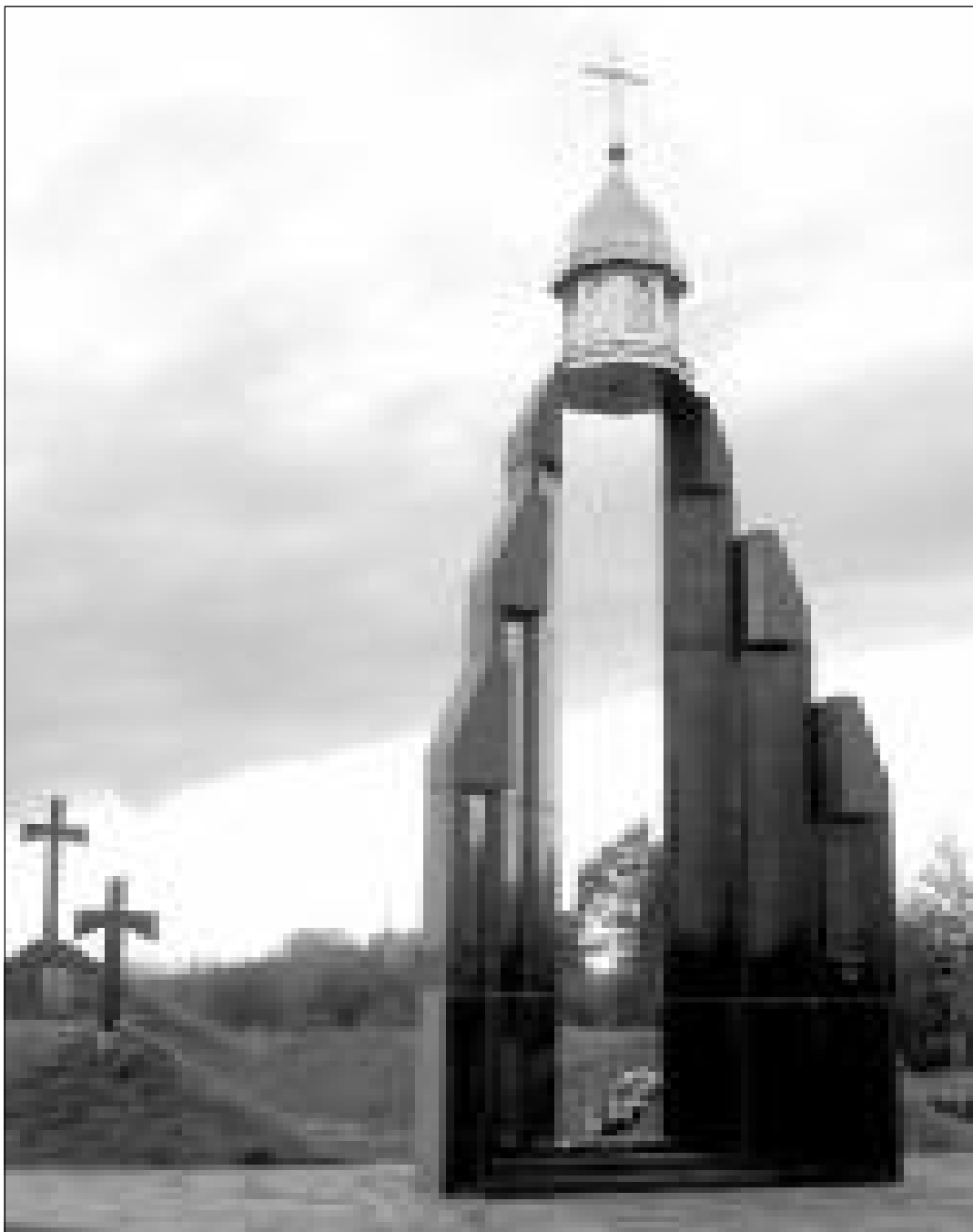
Меморіал воїнам армії УНР – учасникам 2-го Зимового походу, м-ко Базар Народицького р-ну. Автор арх. О. Борис, 2000 р. Фото Г. Мокрицького.
