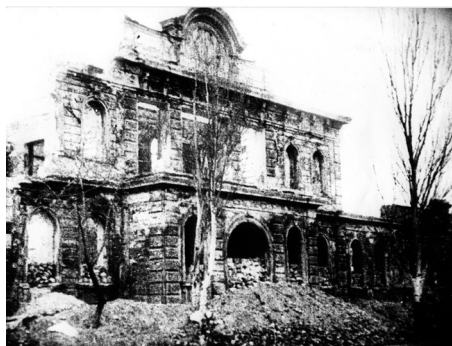
Зруйнована будівля педагогічного інституту. Миколаїв. 1944 р.
