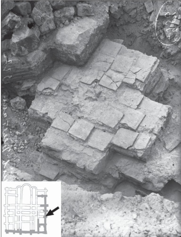
Рис. 10. Десятинная церковь. 1937 г. Остатки апсиды моголянской церкви. Крестчатый пилон открытой южной галереи X в. (между 2-м и 3-м западными пряслами фундаментов). Вид с востока (НА ИА НАНУ Нег. 7956)
