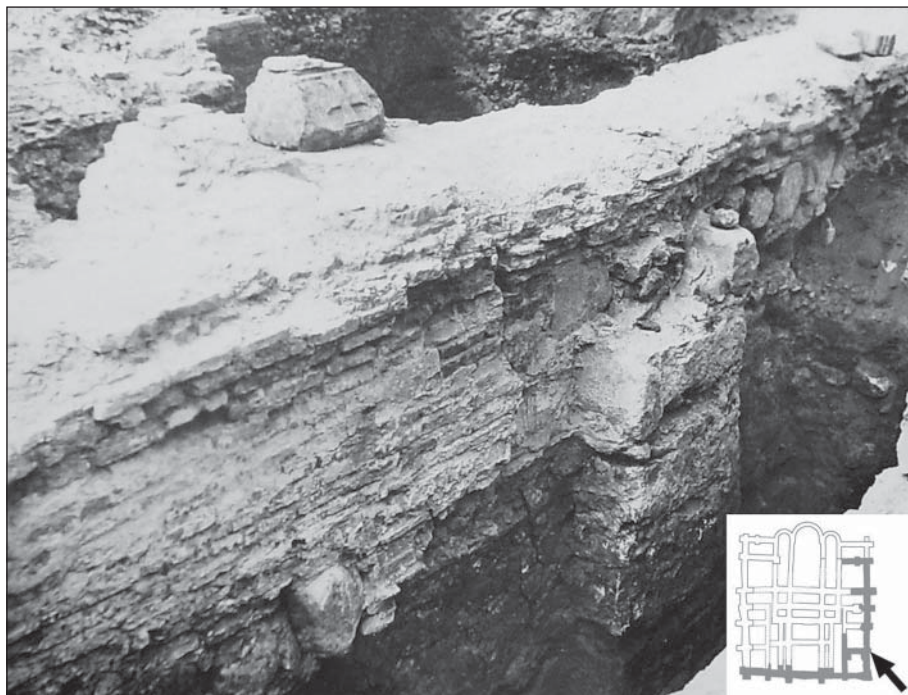
Рис. 11. Десятинная церковь. 1938 г. Фундаменты и стены двух западных прясел южной стены. Вид с юга (ФА ИИМК РАН. О 3312–114)
