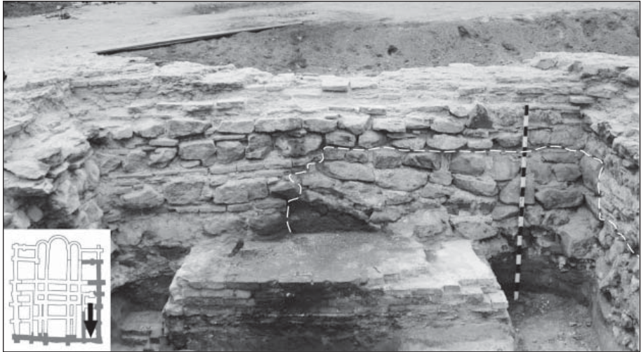
Рис. 5. Десятинная церковь. 2008 г. Юго-западный компартимент. Южное прясло фундаментов западной стены. Вид с северо-востока. Пунктиром показано место примыкания ремонтных кладок XII в. к кладкам X в.
