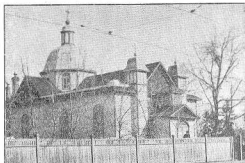
Церква св. Йосафата в Едмонтоні, Алта. Значно пошкоджена в 1913 р.
