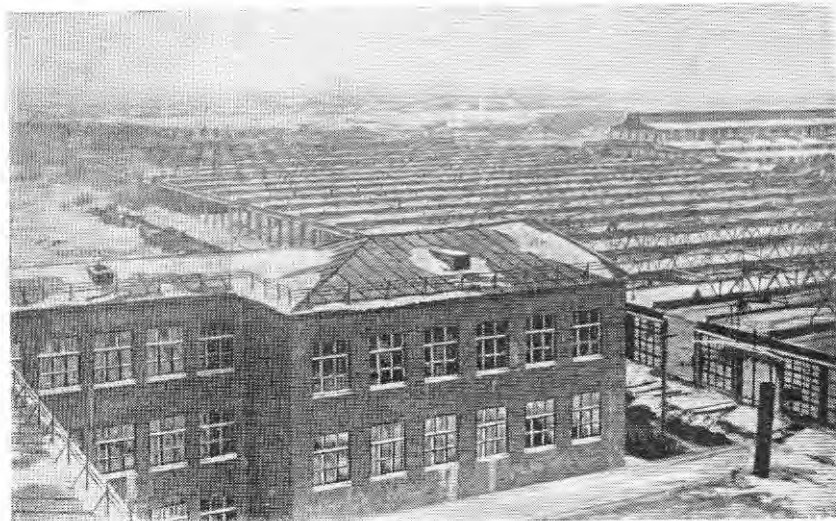
Загальний вигляд будівництва Харківського тракторного заводу (1930 р.).
