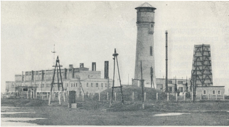
Загальний вигляд газопідстанції в снт. Ратному. 1964 р.
