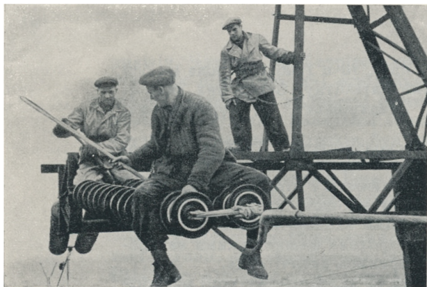
Монтаж високовольтної електричної лінії від Добротвірської ДРЕС біля Горохова. 1967 р.
