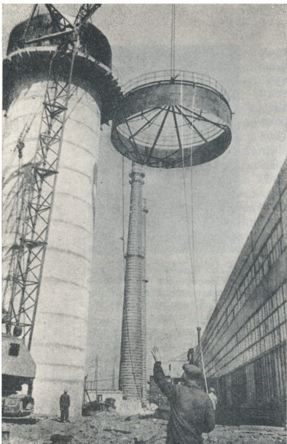
Монтаж резервуарної водонапірної башти на металургійному заводі. Новомосковськ, 1966 р.
