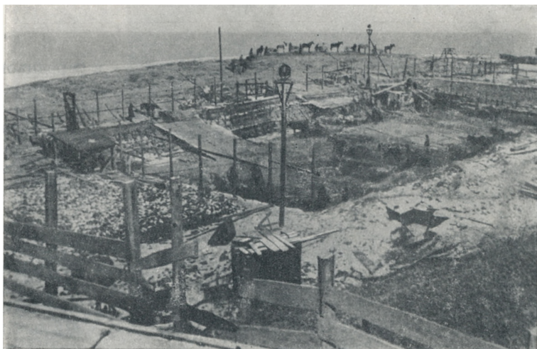
Будівництво Дніпродзержинської районної електростанції. 1930 р.
