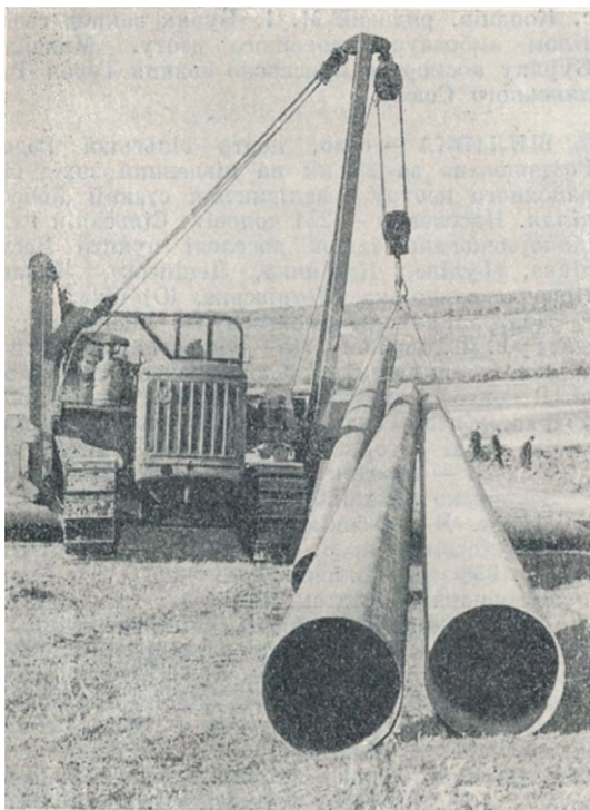
Будівництво зрошувальної системи у колгоспі «Перемога» с. Грузького. 1969 р.
