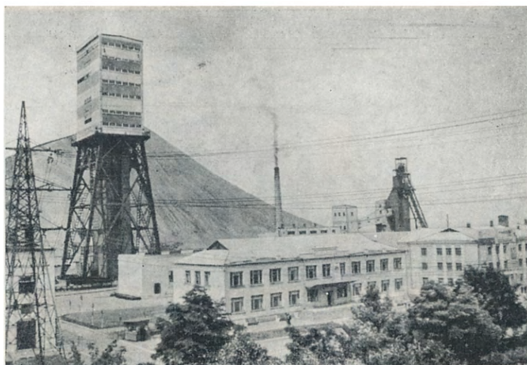
Наземні будівлі шахти № 1 «Центральна». 1967 р.
