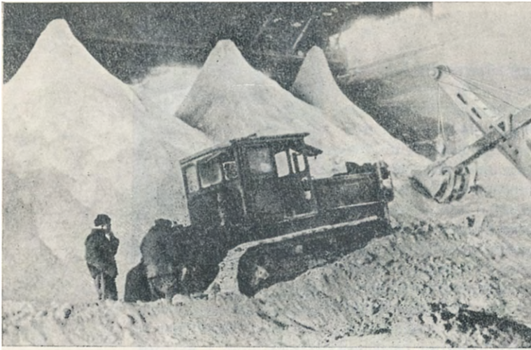
На подвір'ї суперфосфатного цеху Костянтинівського хімічного заводу. 1968 р.
