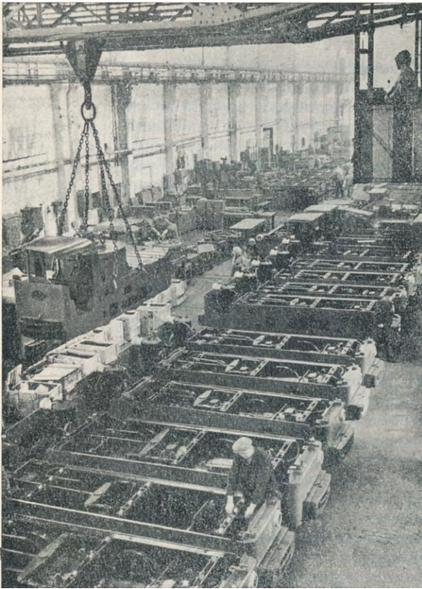
Складання шахтних електровозів на Дружківському машинобудівному заводі. 1968 р.
