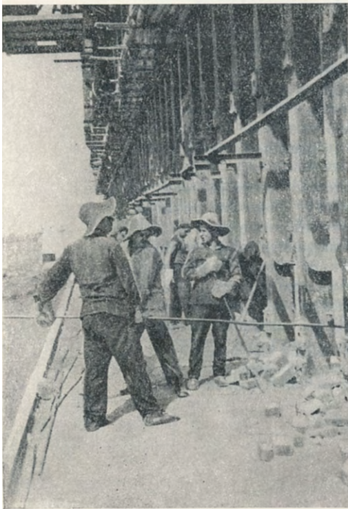
На будівництві коксової батареї Авдіївського коксохімічного заводу. 1963 р.
