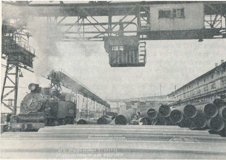
Склад готової продукції Харцизького трубного заводу. 1963 р.
