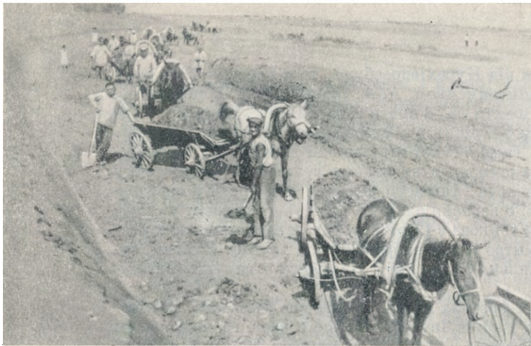
На будівництві Курахівської ДРЕС. 1934 р.
