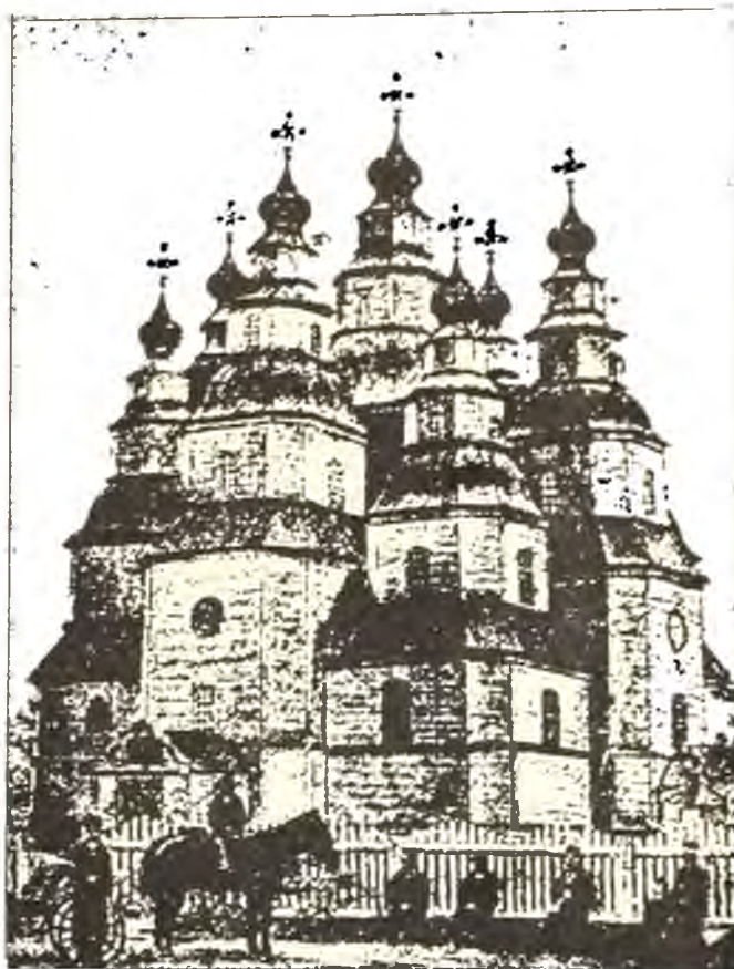
364. Запорозька церква в Самарі (Новомосковську) збудована в рр. 1773-9.
