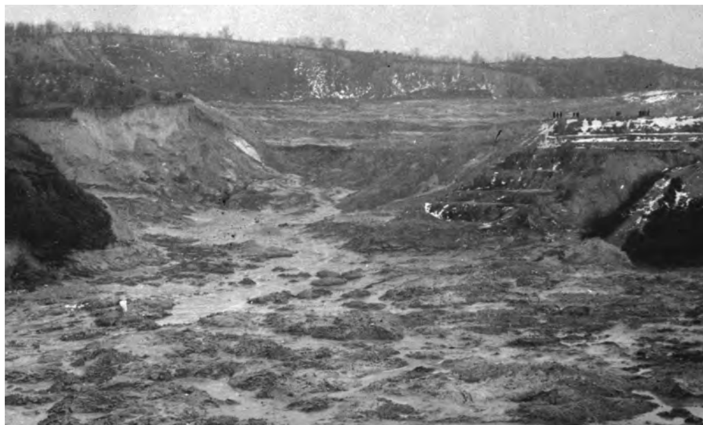
№ 35. Вид на зруйнований гідровідвал у відрозі № 3 з боку міста. Праворуч видно вцілілу частину дамби № 1, ліворуч – зруйновану частину правого берегу. На передньому плані залишки ґрунтової маси, що витекла за межі гідровідвалу.
