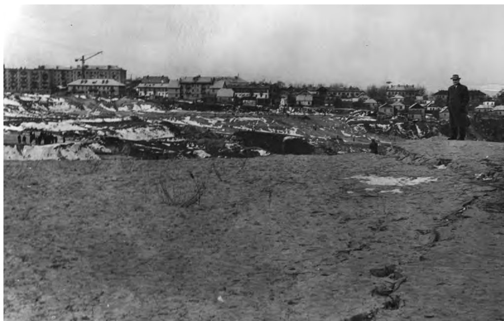
№ 39. Закол (тріщина) вцілілої частини ділянки № 1 зі сторони правого берега у відрозі № 3 Бабиного Яру після аварії.
