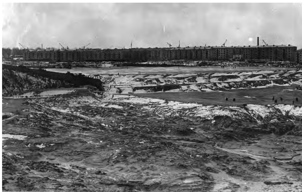
№ 32. Зона руйнування гідровідвалу на ділянці № 3. На задньому плані видно дамбу № 3, а перед нею частина другої ділянки, що залишилася.
