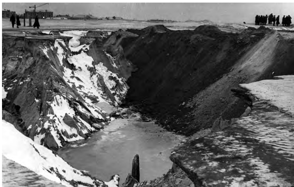
№ 31. Права частина промоїни на ділянці № 3 та дамби № 3 біля правого берега третього відрігу Бабиного Яру після аварії в м. Києві.
