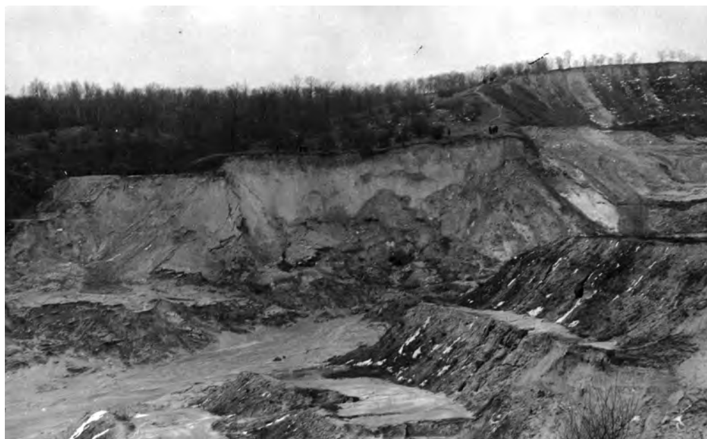
№ 42. Зона виносу на ділянці № 1. Праворуч в кутку видно уцілілу частину дамби № 1, ліворуч – обвалений корінний берег.
