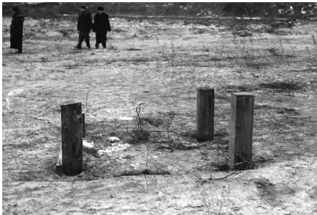
№ 33. Замулений зливний водоскидний колодязь на ділянці № 2.
