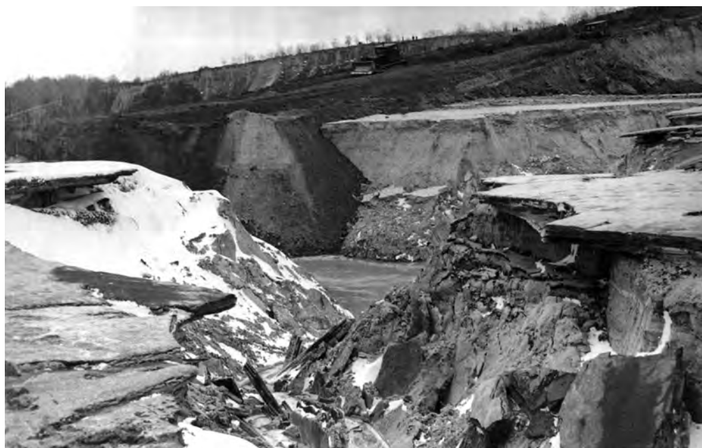
№ 30. Ліва частина промоїни на ділянці № 3 та дамби № 3 біля правого берега третього відрігу Бабиного Яру після аварії у м. Києві
