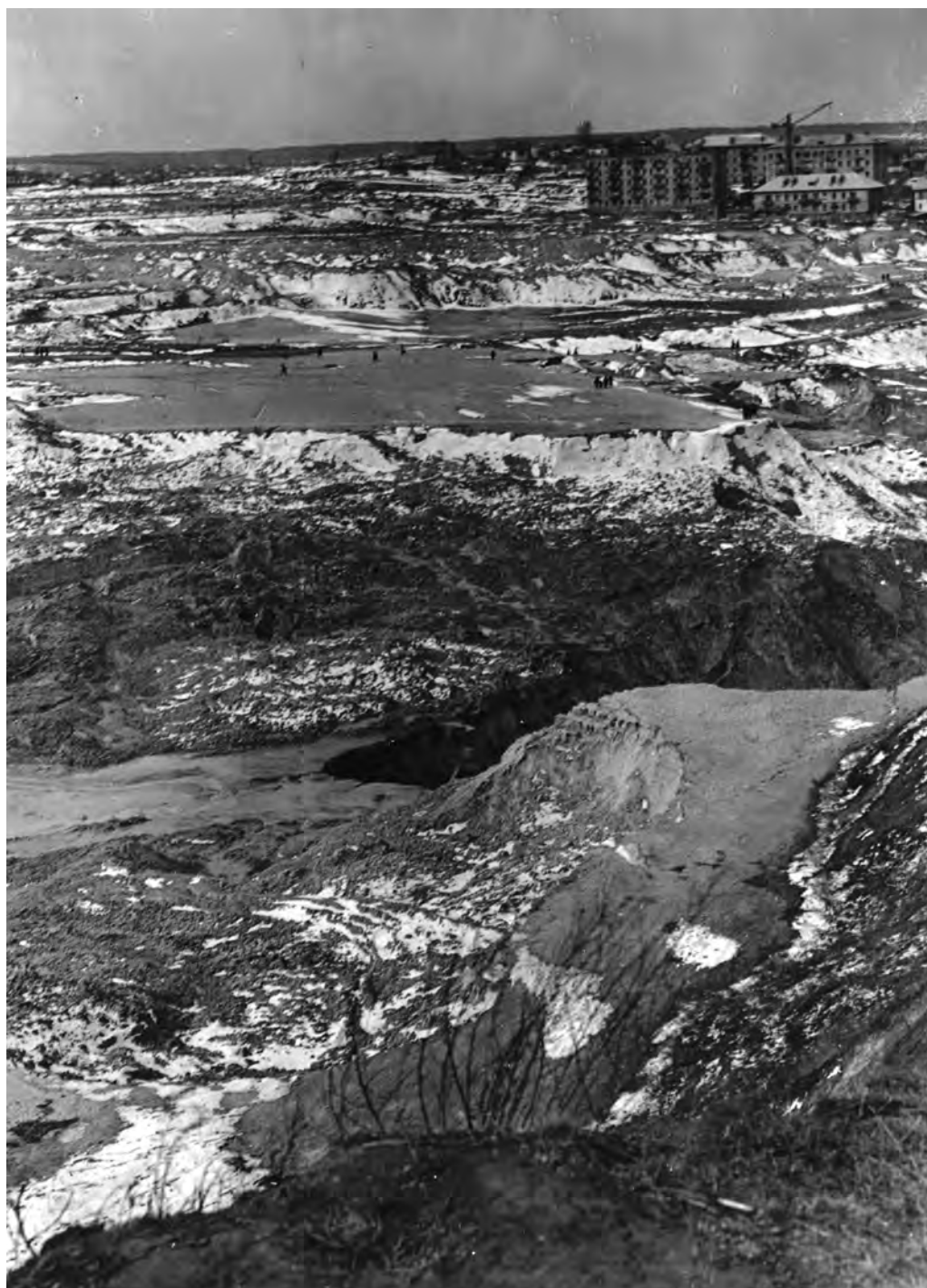
№ 38. Вид з високого правого берегу на зону виносу ділянки № 1. Зверху і по середині ліворуч видно залишки вцілілої ділянки № 1, а по середині між ними – найглибша частина зони виносу.
