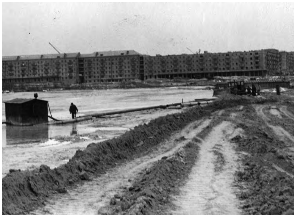
№ 28. Карта наміву № 4 на ділянці № 3, де проводився намів. Зліва видно насосну станцію для перекачування освітленої води.
