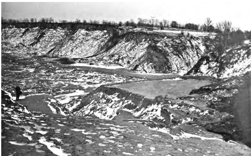
№ 15. Ділянка водойми-накопичувача, що прорвало. Вид з верхньої частини Бабиного Яру. Березень 1961 р.
