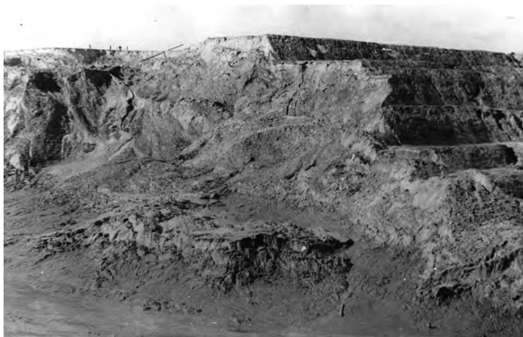
№ 40. Залишок дамби № 1. Вид зі сторони міста. Ліворуч зона виносу на місці зруйнованої частини дамби № 1.
