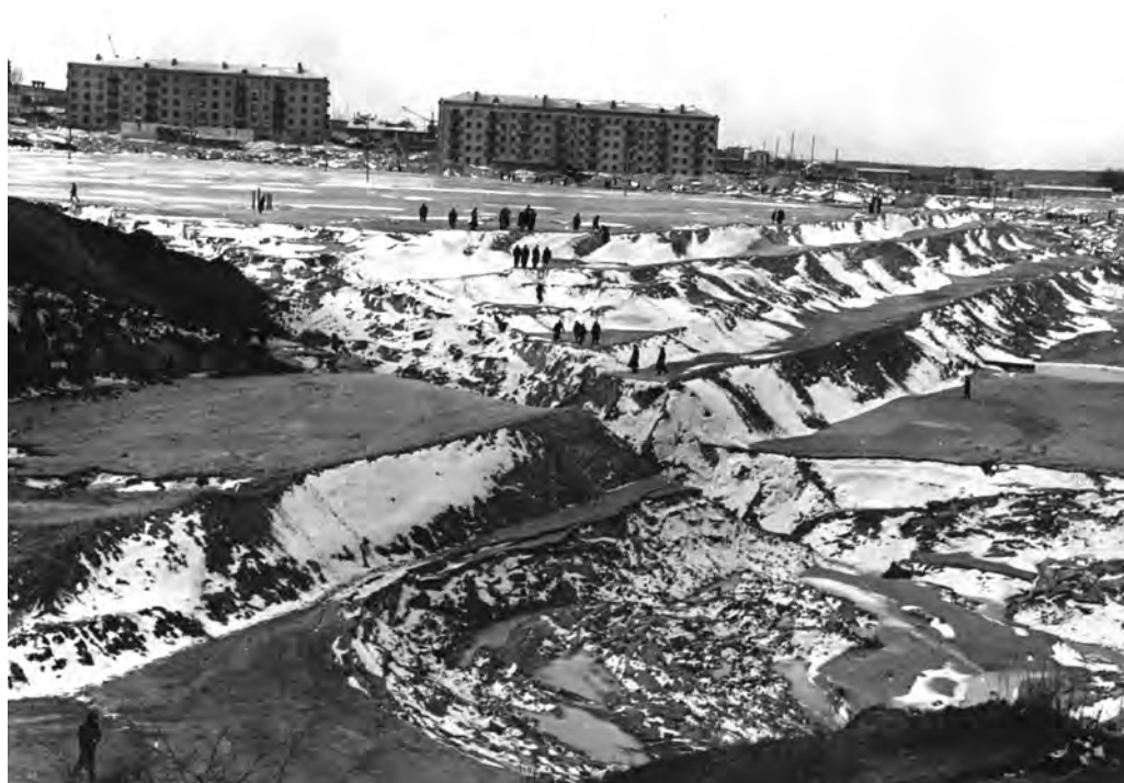
№ 27. Загальний вид гідровідвалу. Зліва видно промоїну в дамбі № 3. На передньому плані – верхня частина зони виносу ґрунту з другої ділянки гідровідвалу.
