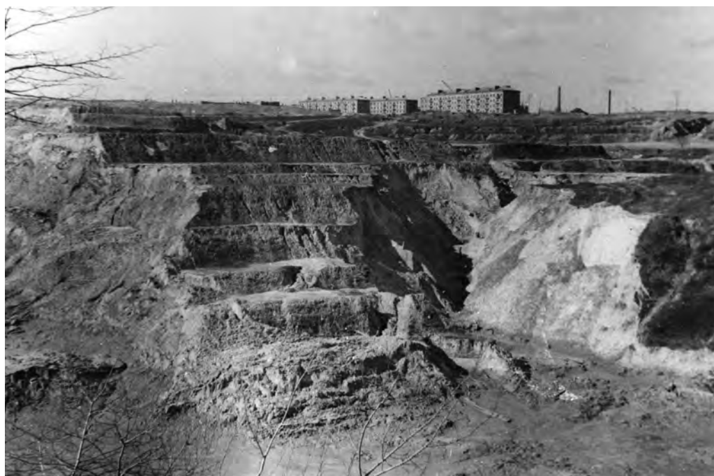
№ 41. Вид зі сторони міста на уцілілу частину дамби № 1. Ліворуч видно зону виносу, праворуч розмив і обвалення середньої частини дамби.
