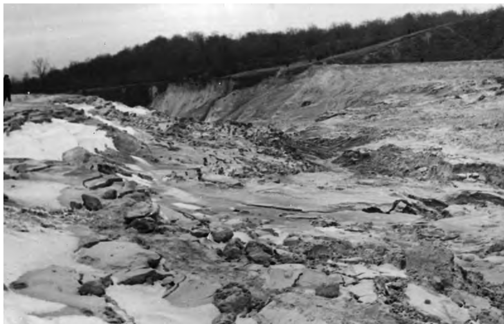
№ 37. Зона виносу в гідровідвалі у відрозі № 3 Бабиного Яру. Вид з верхового боку.
