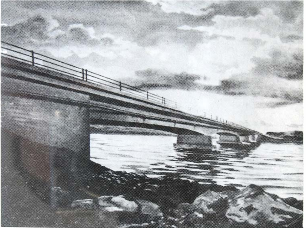
Міст в одній із заморських баз ЗДА, збудований фірмою Лорі і Лепкалюк
