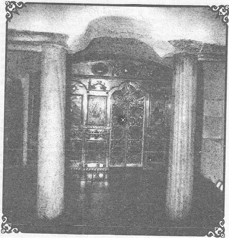
Подземная церковь Антония Печерского.
