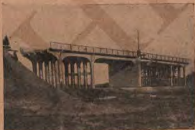
Путепроводъ въ г. Ярославль.
