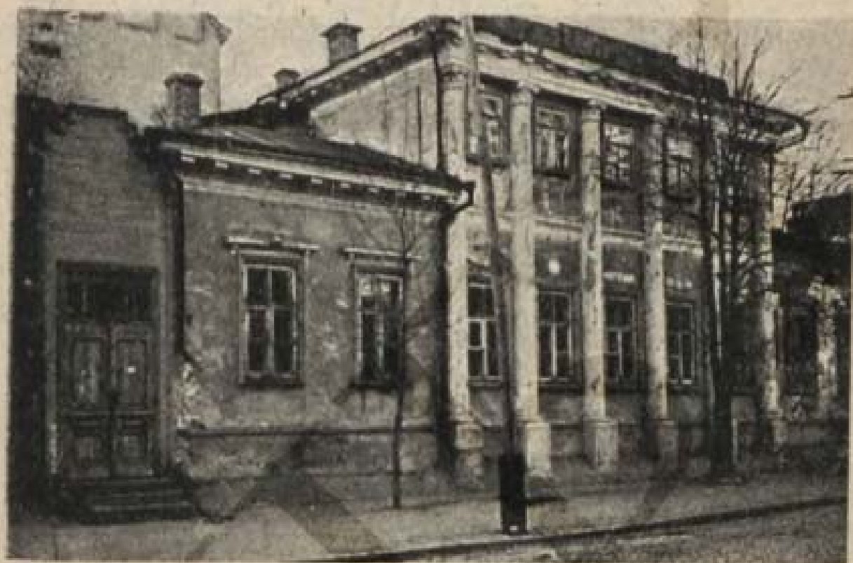
Будинок на вул. Енгельса № 34.
