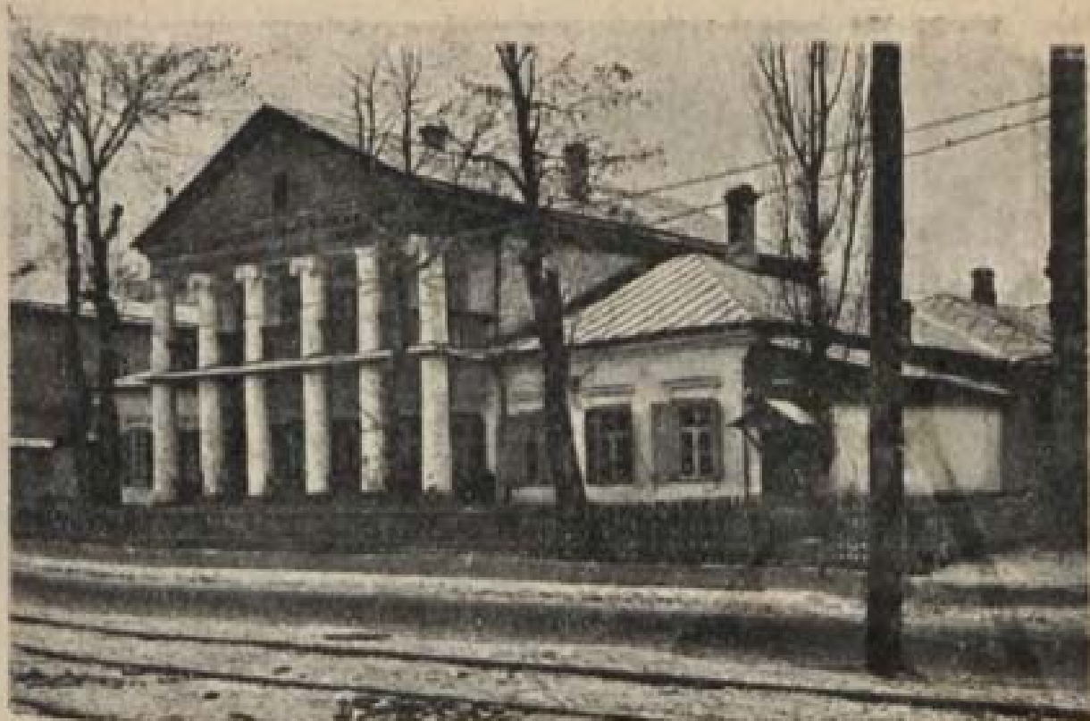
Будинок по вул. Червонопрапорного заводу (Московській) № 40.
