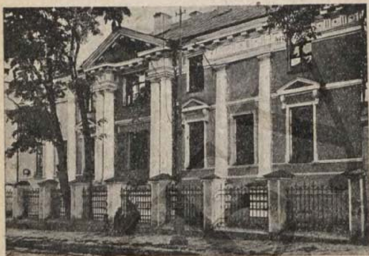
Будинок по Покровській вул. № 5.
