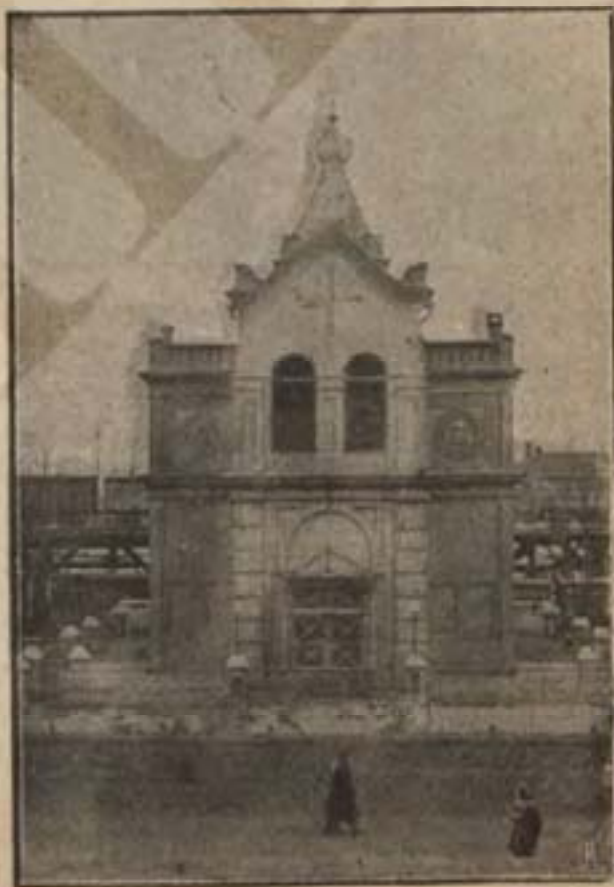
Николаевская приморская церковь.
