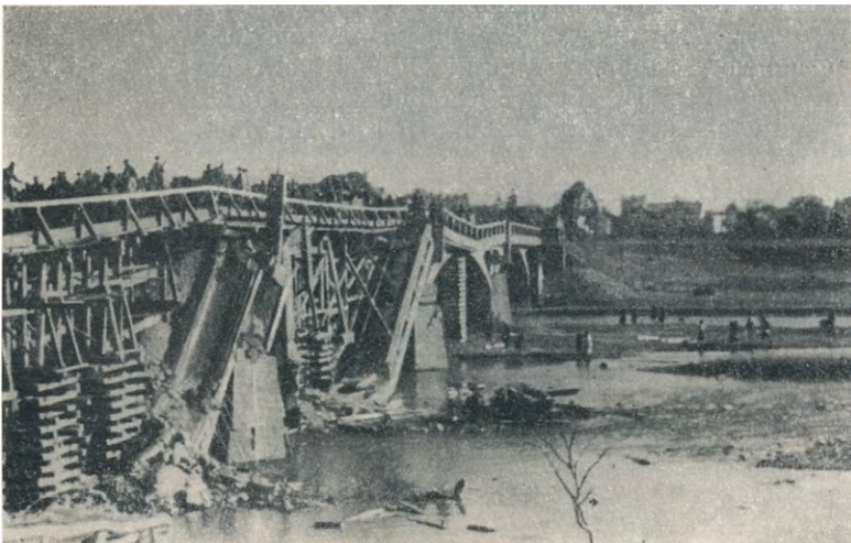
Зруйнований фашистами міст в Ужгороді, 1944 р.
