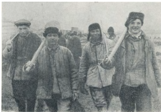
Ударна бригада бетонярів Є. Романько на будівництві Дніпрогесу. Запоріжжя, 1930 р.
