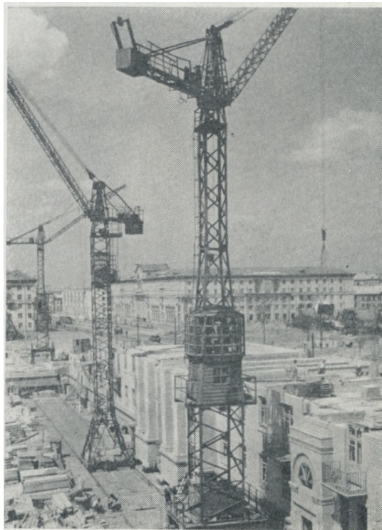
Спорудження житлових будинків для металургів Запоріжжя. 1956 р.
