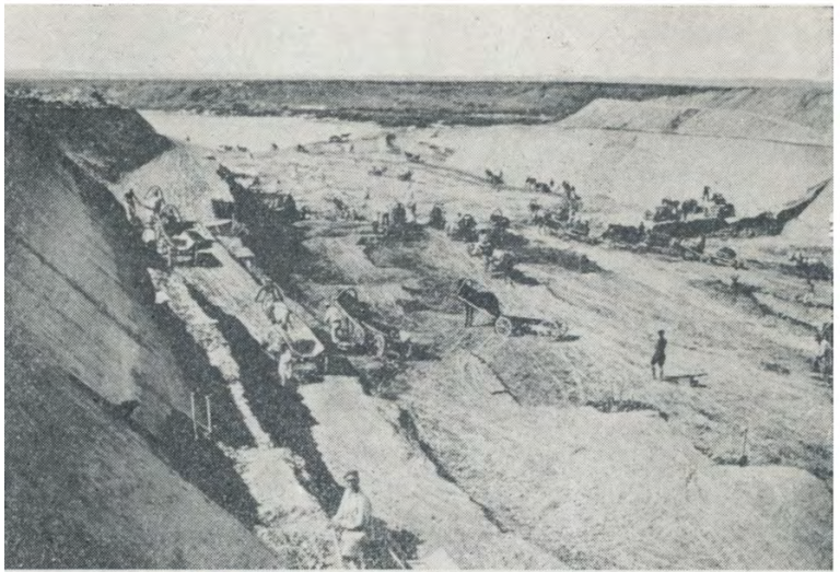
Габарі на будівництві Дніпрельстану. Запоріжжя, 1927 р.
