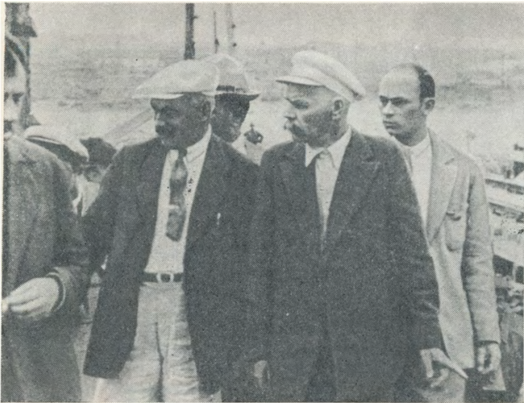
О. М. Горький на будівництві Дніпрогесу в супроводі заступника головного інженера будови П. П. Ротерта (зліва). Запоріжжя, 1928 р.
