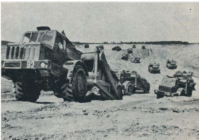
Землерийна техніка на будівництві Північно-Кримського каналу. 1965 р.
