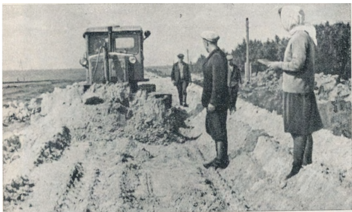
На будівництві дороги з твердим покриттям від Інгуро-Кам'янки до райцентру. 1969 р.
