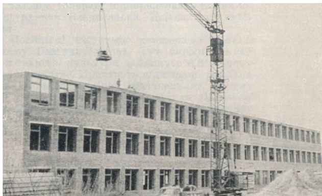
Будівництво середньої школи у Вільшанці. 1972 р.
