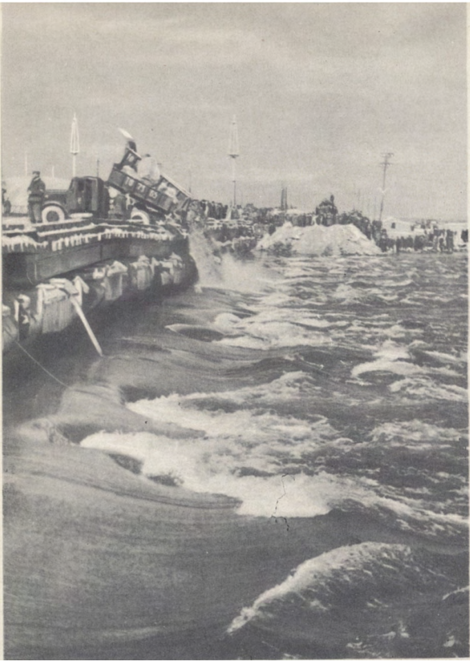
Перекриття русла Дніпра на спорудженні Кременчуцької ГЕС. 1959 р.
