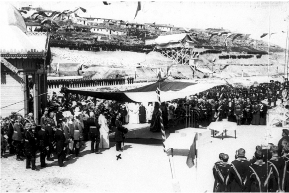
Освящение Северного дока в присутствии императора Николая II. Из фондов ГАГС.
