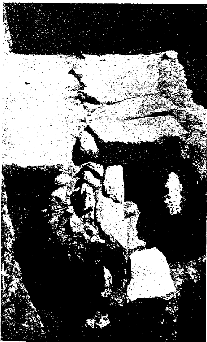
Рис. 21. Водосточный канал № 33 с частично снятыми плитами перекрытия, вид с запада.
