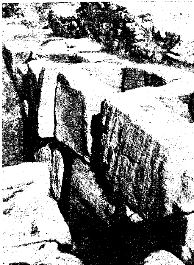
Рис. 18. Облицовка наружных стен рыбозасолочных ванн (кладка п о 10), вид с юго-запада.
