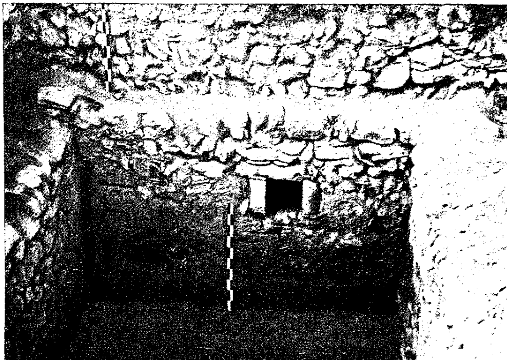
Рис. 89. Кладовая в помещении II (вид с северо-запада).
