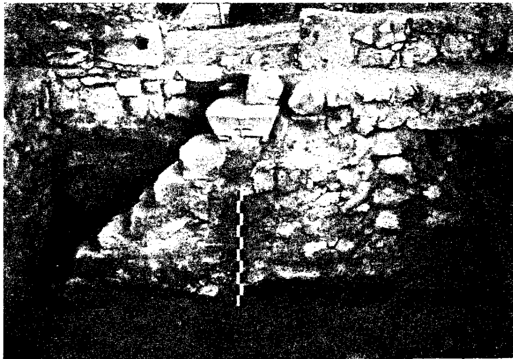
Рис. 87. Юго-восточная стена с лестницей в помещении VI.
