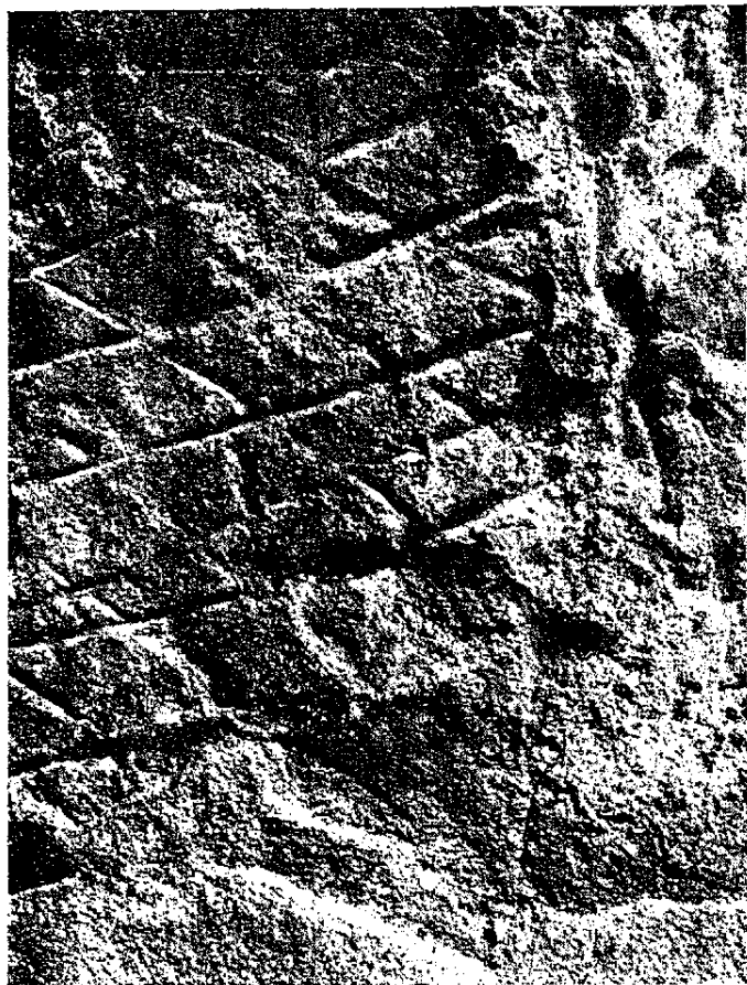
Рис. 16. Цементированная стена внутри одной из рыбозасолочных ванн.
