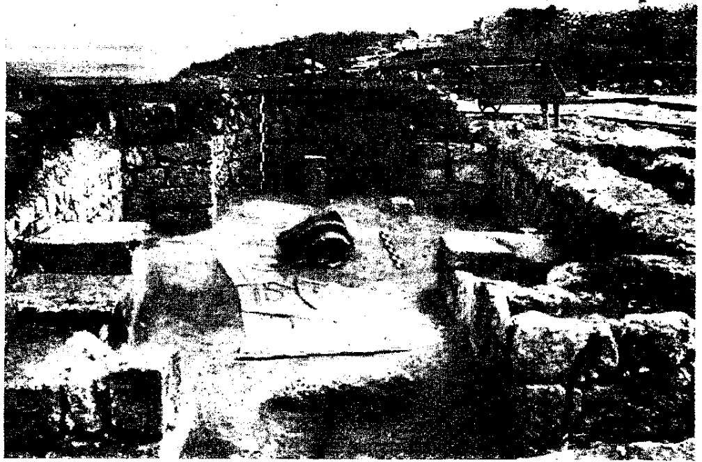
Рис. 66. Часовня (внутренний вид с юго-запада).
