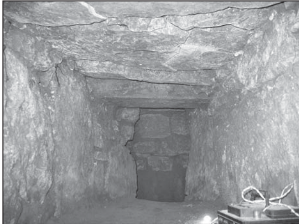
Рис. 2. Подземный ход около устья колодца. Вид с севера
