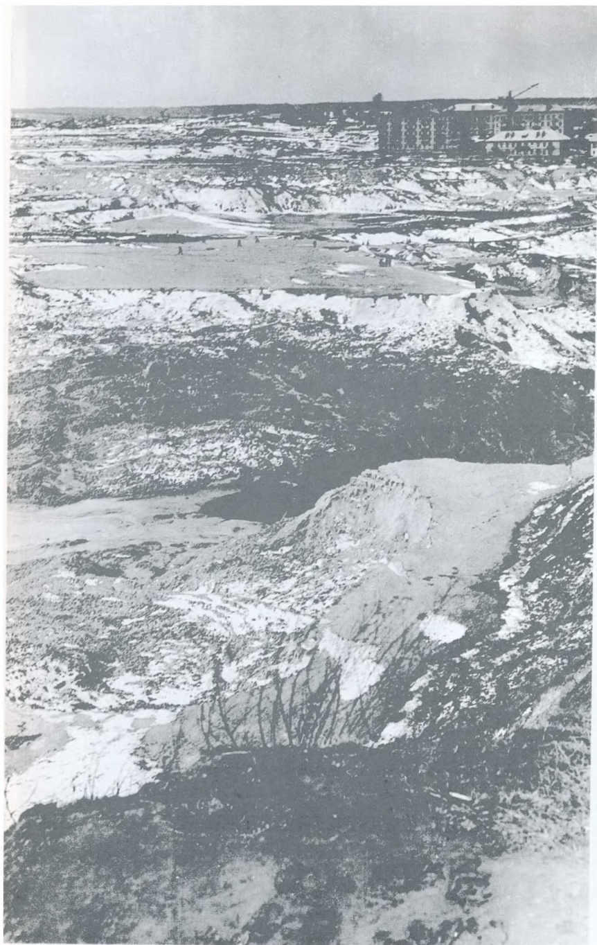
Фото 77. Вид с высокого правого берега на область выноса участка № 1. Сверху и в середине слева видны остатки уцелевшего участка № 1, а в середине между ними — самая глубокая часть области выноса. Март 1961 г.
