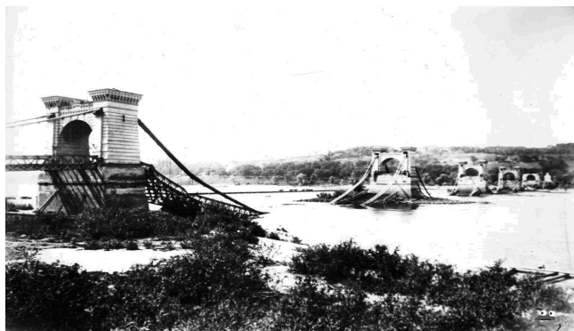
Николаевский мост в Киеве, разрушенный поляками в 21 году
