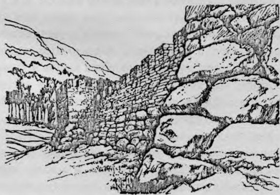
Рис. 65. Римская крепость Хара́кс. Циклопический участок нижней оборонительной стены. Реконструкция. По К.К. Орлову
