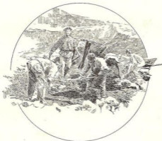
Работы въ траншеяхъ.
