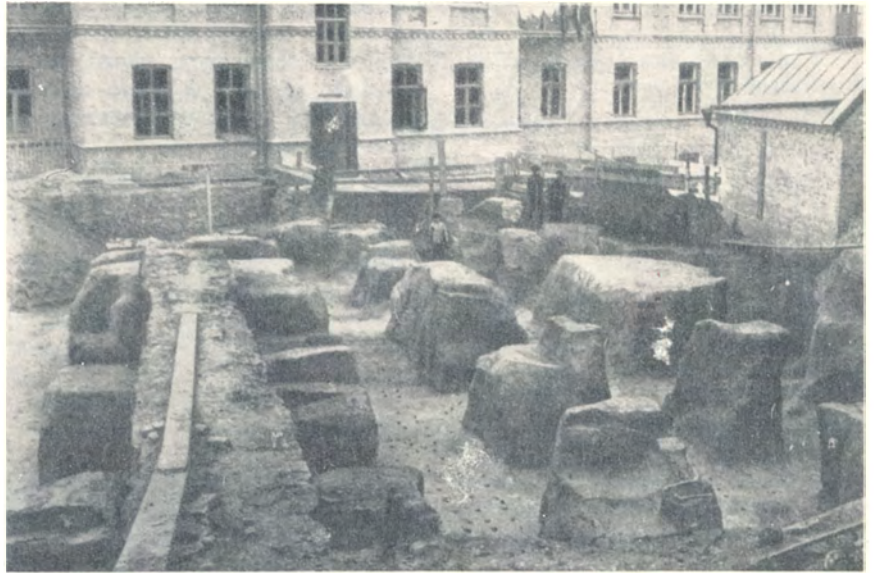
130. Фундамент церкви Трини (Орини) в Києві. XI ст.
