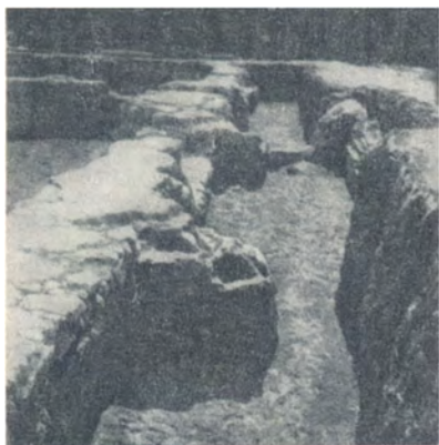
90. Десятинна церква. Фундамент західної стіни. X ст.
