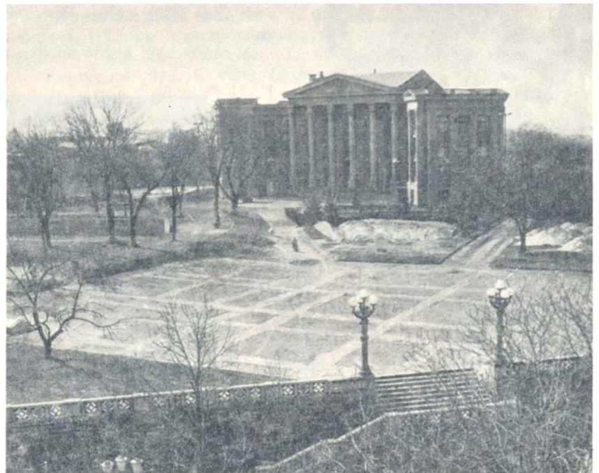
104. Обрис фундаментів Десятинної церкви, викладений каменем. Сучасний вигляд.
