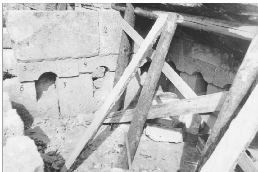
Рис. 11. Внутренняя сторона западной стены склепа № 1013 с нишей.
