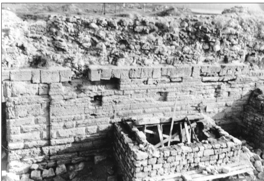
Рис. 13. Раскреповка наружной стороны 16-й куртины. Виден левый вертикальный шов.
