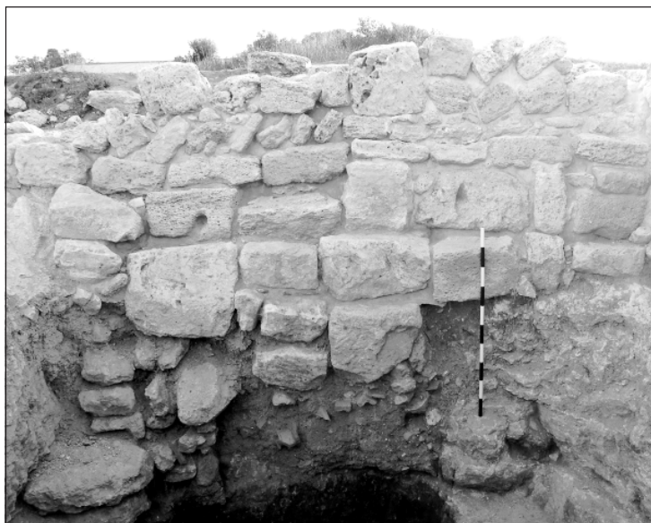
Рис. 9. Фундамент стены помещения 38, выходящей на поперечную улицу.
