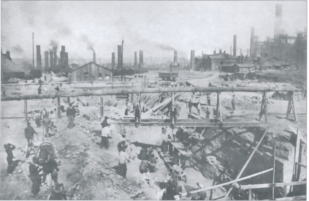
27.6. Будівництво металургійного заводу в Юзівці (нині Донецьк) – головному промисловому центрі Донбасу (1911)
