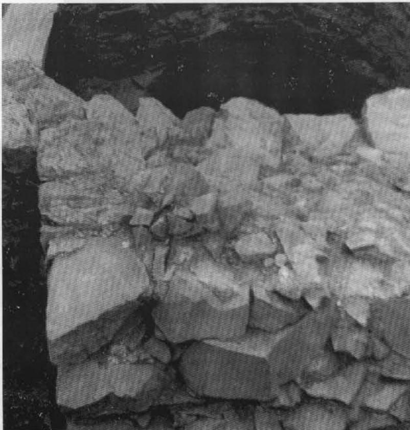
Рис. 141. Фрагмент кладки, примыкающий к башне № 1 с юго-запада
