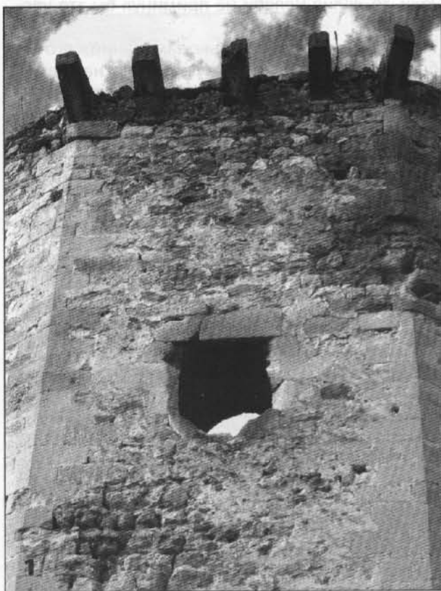
Рис. 98. Окно-бойница третьего этажа южной грани Чоргунской башни: 1 – верхняя часть башни с окном и кронштейнами; 2 – юго-восточные грани башни (вид с юго-востока)
