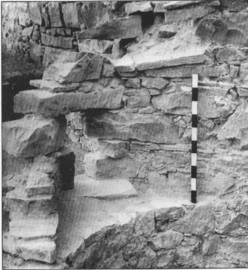
Рис. 156. Юго-восточная бойница северной башни (№ 2). Вид изнутри и с севера
