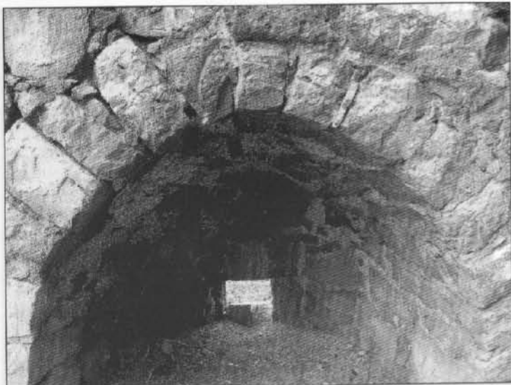
Рис. 291. Амбразура нижнего яруса обороны в северо-восточной стене башни Криско. Вид с юго-запада и изнутри
