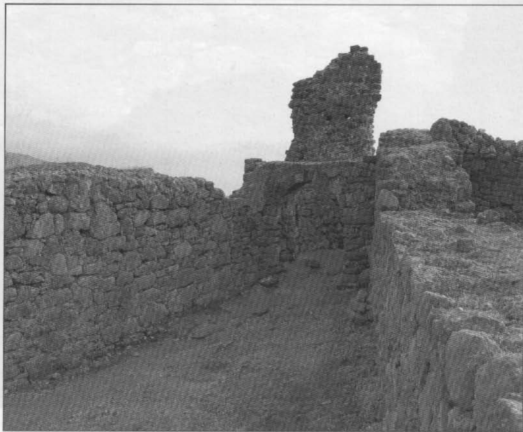
Рис. 236. Внутренний дворик («захаб») между донжоном и церковью 1459 г. Вид с севера
