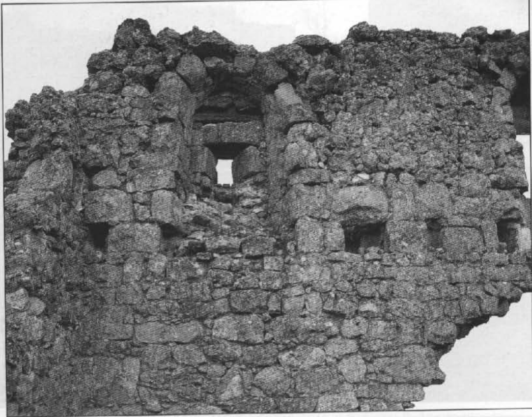
Рис. 252. Окно в северо-восточной стене донжона на уровне третьего этажа, превращенное в амбразуру (вид с юго-запада).
