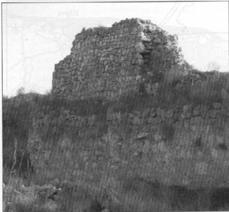
Рис. 17. Доформированная кладка оборонительной стены Каламиты и подпирающая её куртина (вид с запада)
