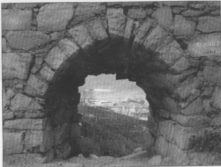
Рис. 292. Амбразура нижнего яруса обороны в северо-восточной стене башни Криско. Вид с северо-запада и изнутри
