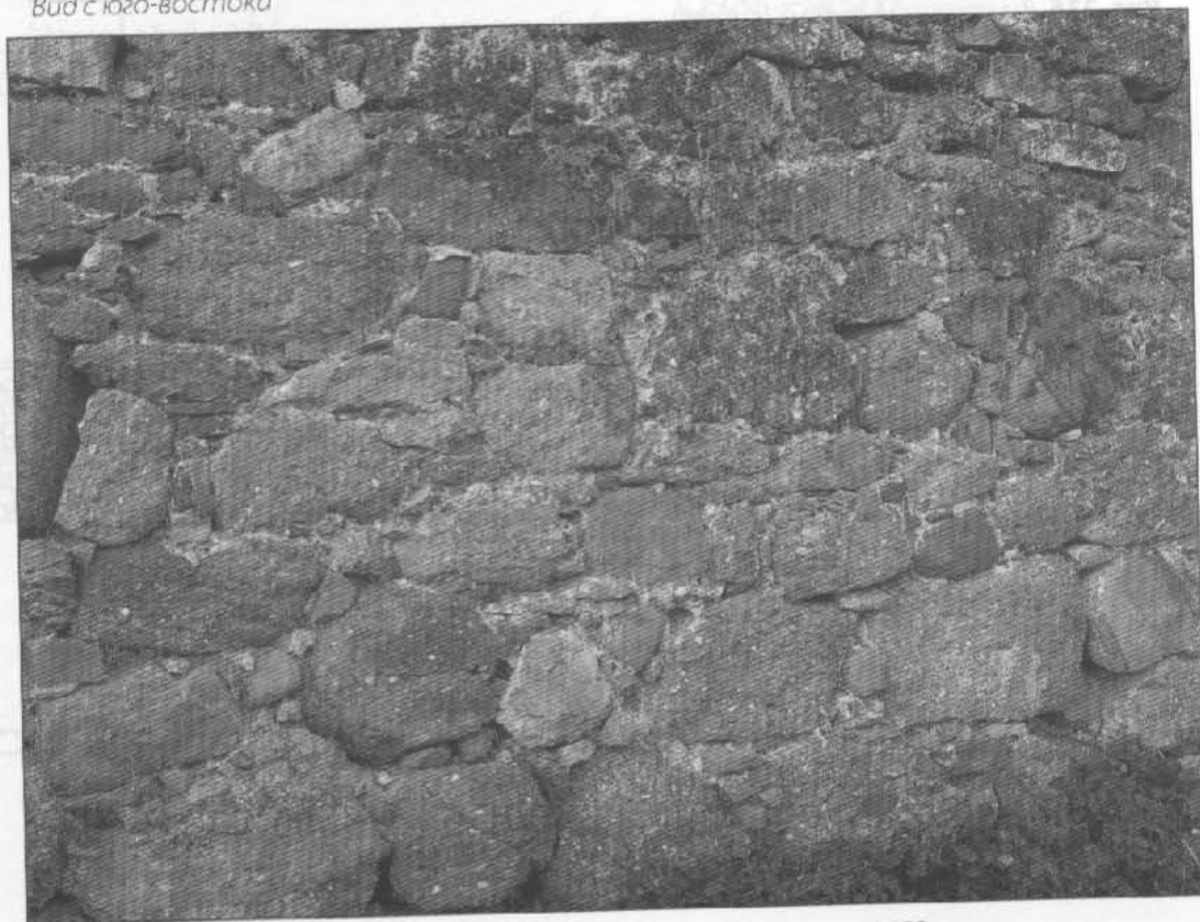
Рис. 239. Деталь кладки крепостной стены 1459 г.
