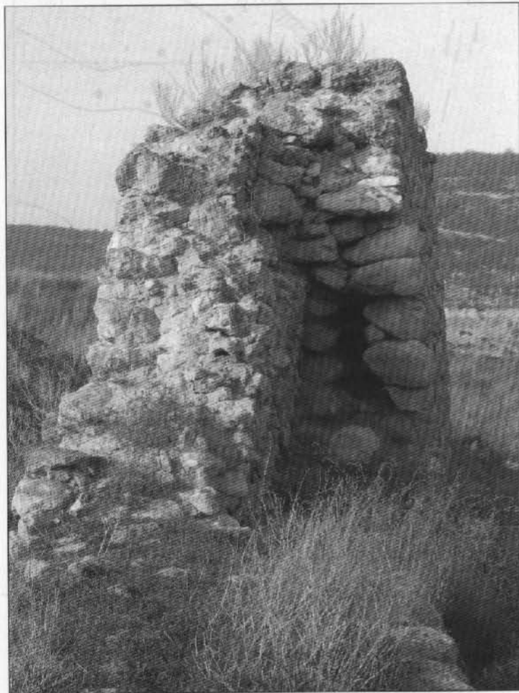
Рис. 18. Следы деформации крепостной стены Каламиты
