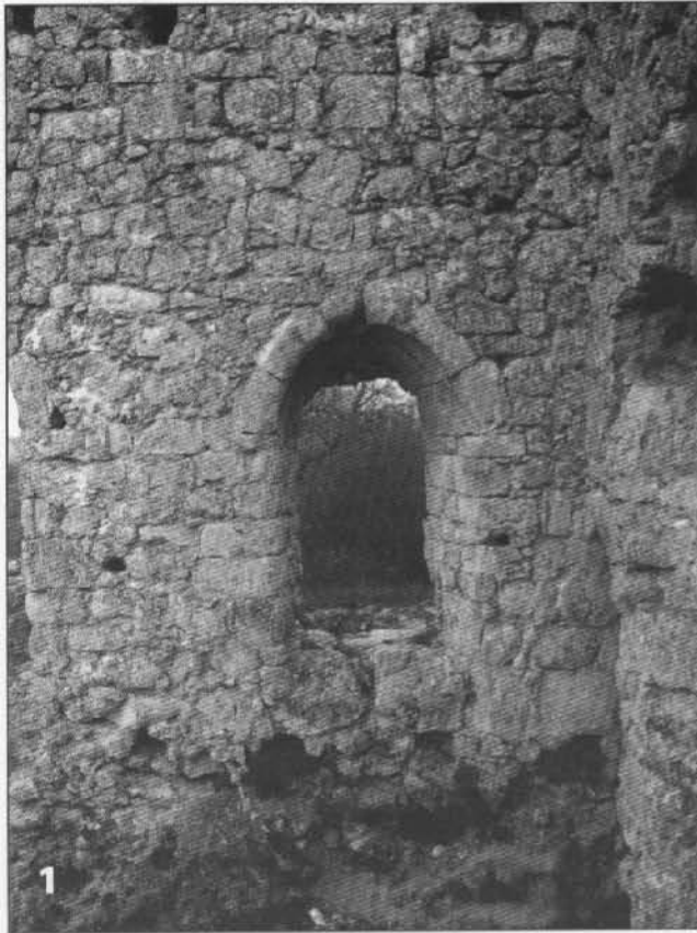
Рис. 255. Внутренняя сторона северо-восточной стены донжона: 1 – дверной проём второго этажа; 2 – оконный проём, превращенный в бойницу (вид с юго-запада)
