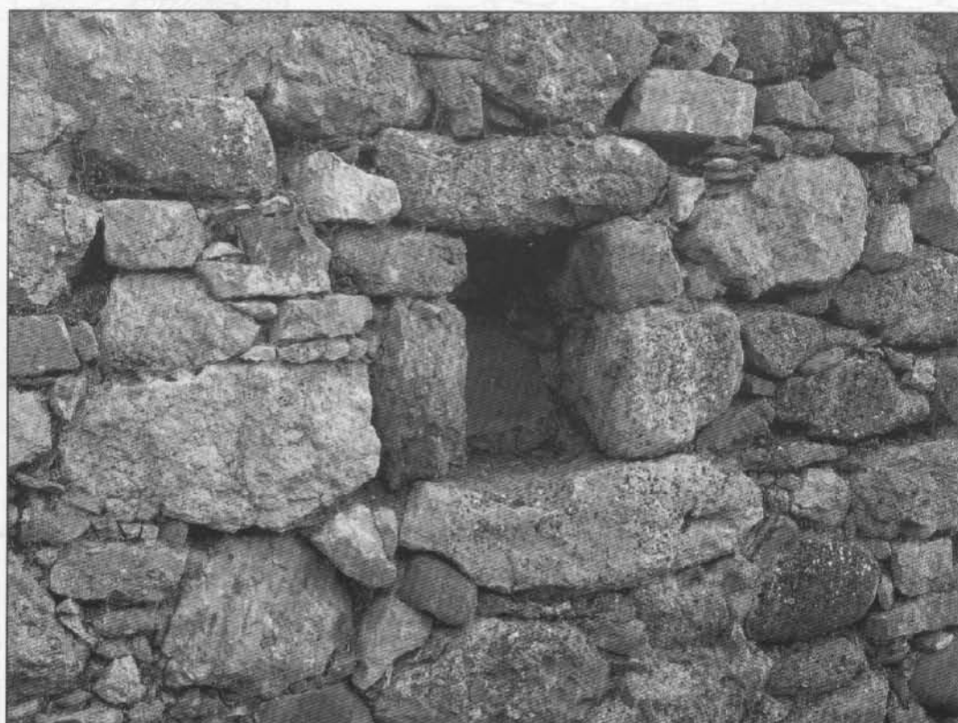
Рис. 241. Ниша для светильника (?) в крепостной стене 1459 г.
