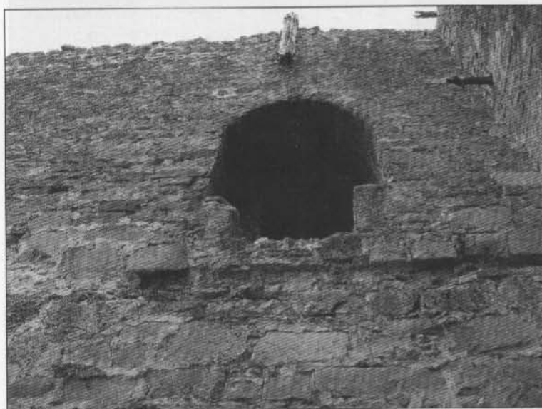
Рис. 289. Амбразура второго яруса обороны в юго-восточной стене башни Криско. Вид с северо-запада и изнутри
