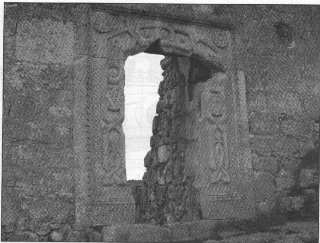
Рис. 258. Главный северо-восточный вход в донжон цитадели Мангуна (вид с северо-востока)
