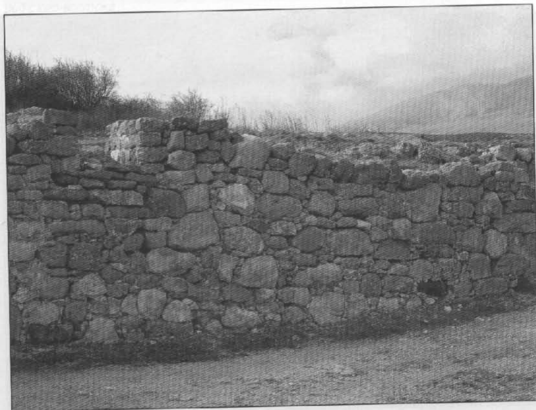
Рис. 243. Внешняя (восточная) стена донжона 1459 г. Вид с юго-востока
