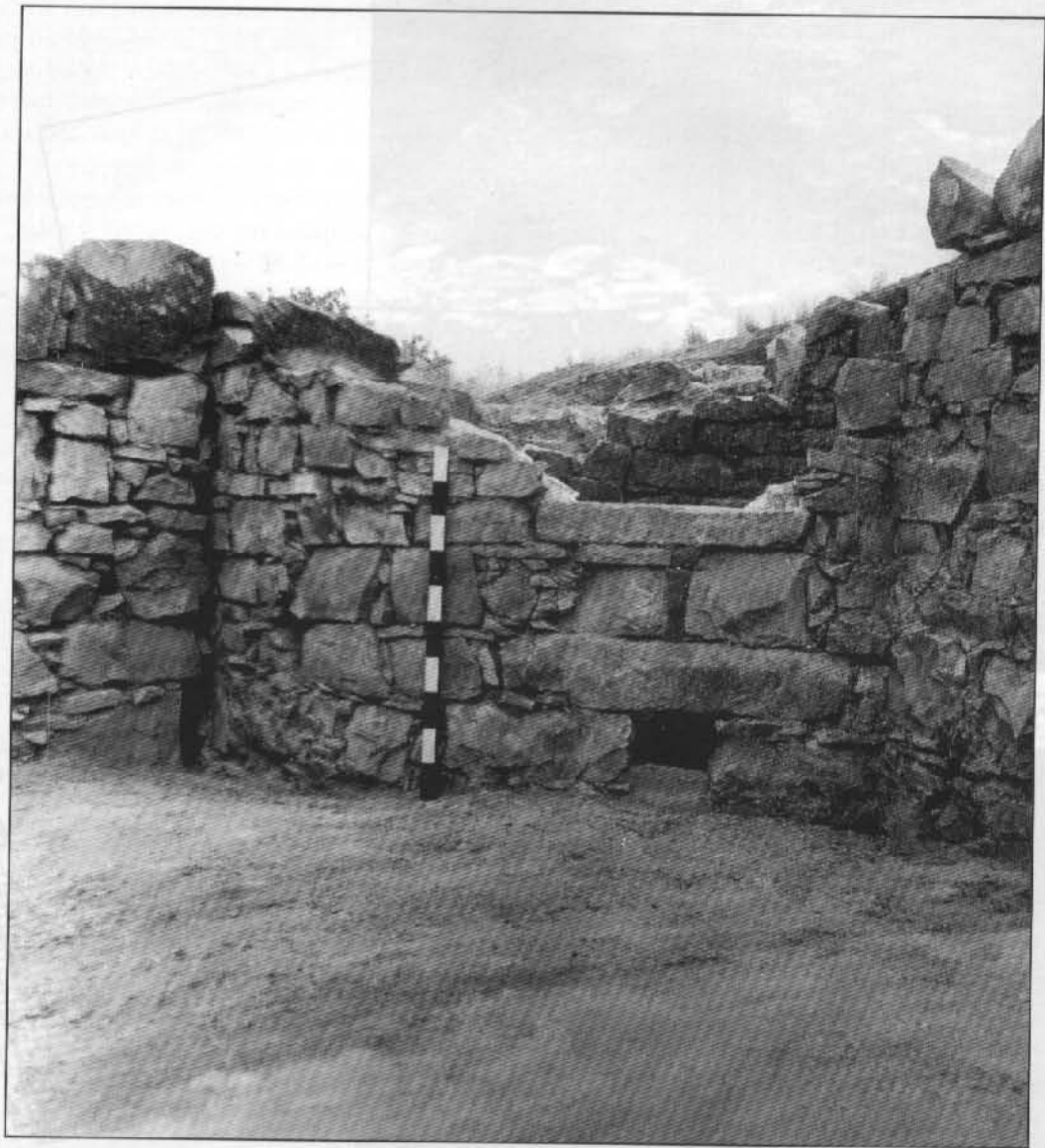
Рис. 139. Башня № 1 с амбразурами подножного боя. Вид с севера
