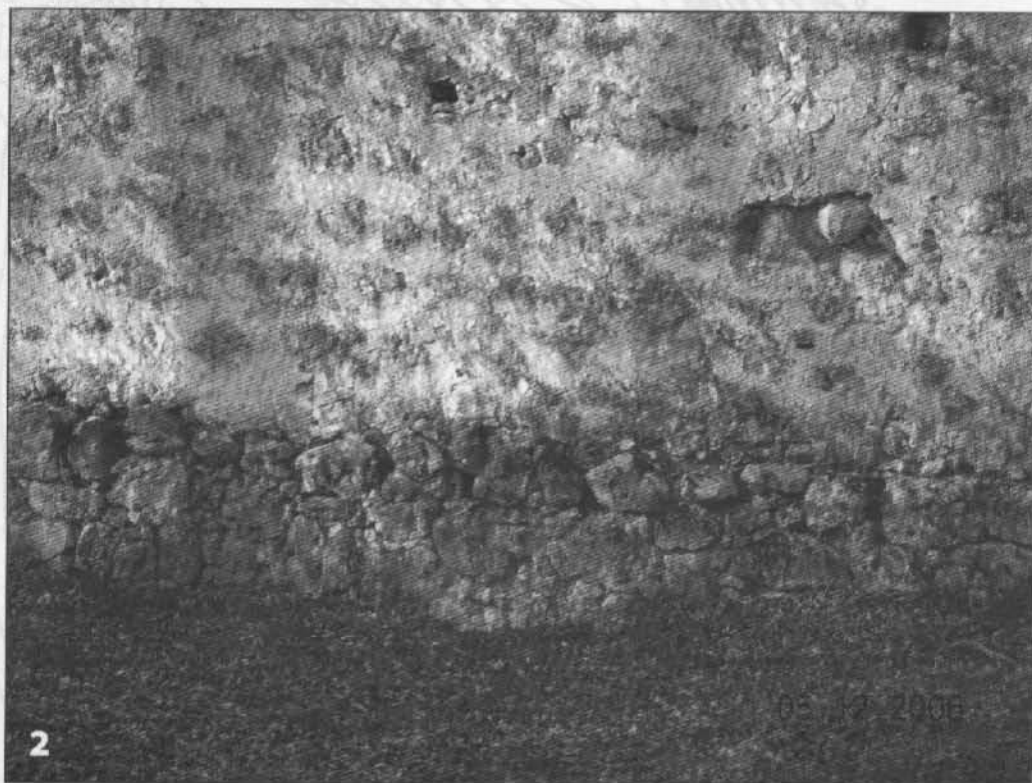
Рис. 88. Вторая линия обороны Мангупа в верховье балки Табана-Дере: 1 – сохранившийся участок стены; 2 – в основании видна кладка первого («феодоритского») строительного периода (вид с юго-востока)
