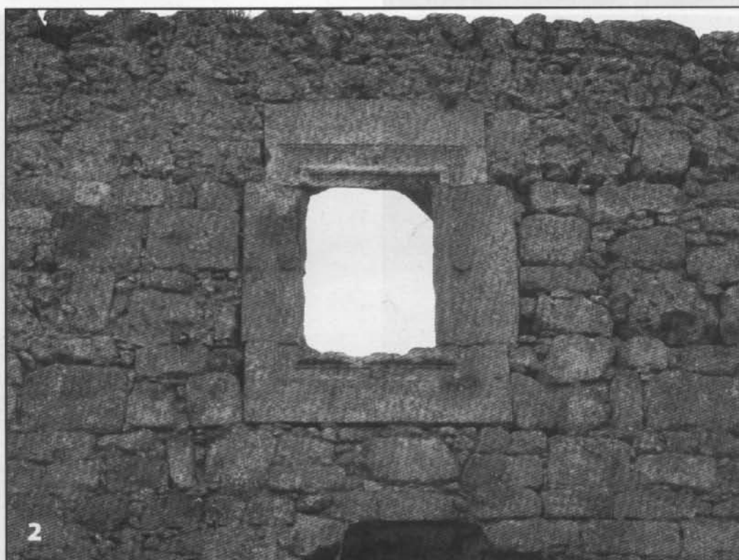
Рис. 254. Окна третьего этажа донжона цитадели Мангула, обращенные на северо-восток: 1 – оконный проём, превращенный в бойницу над парадным входом; 2 – центральное окно здания (вид с северо-востока)
