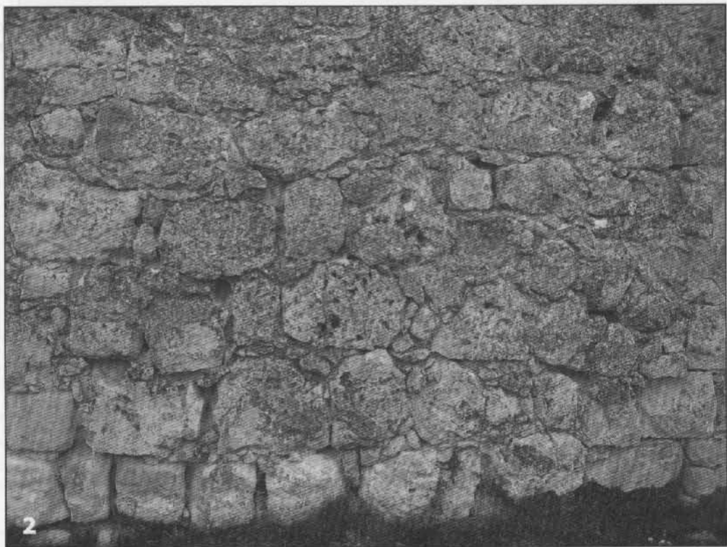
Рис. 87. Детали кладки юго-западной башни второй линии обороны Феодоро: 1 – кладка средней части башни; 2 – основание башни (вид с запада)
