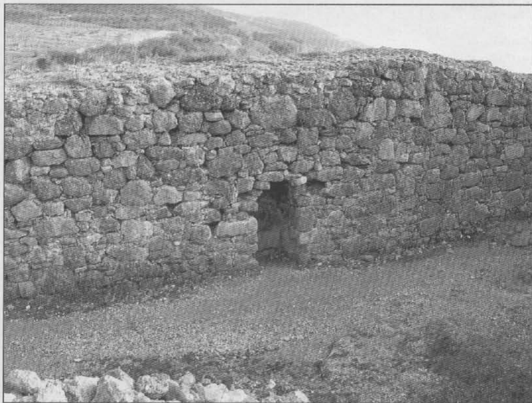
Рис. 237. Крепостная стена, прикрывающая с юго-востока крепостной дворик. Вид с юга
