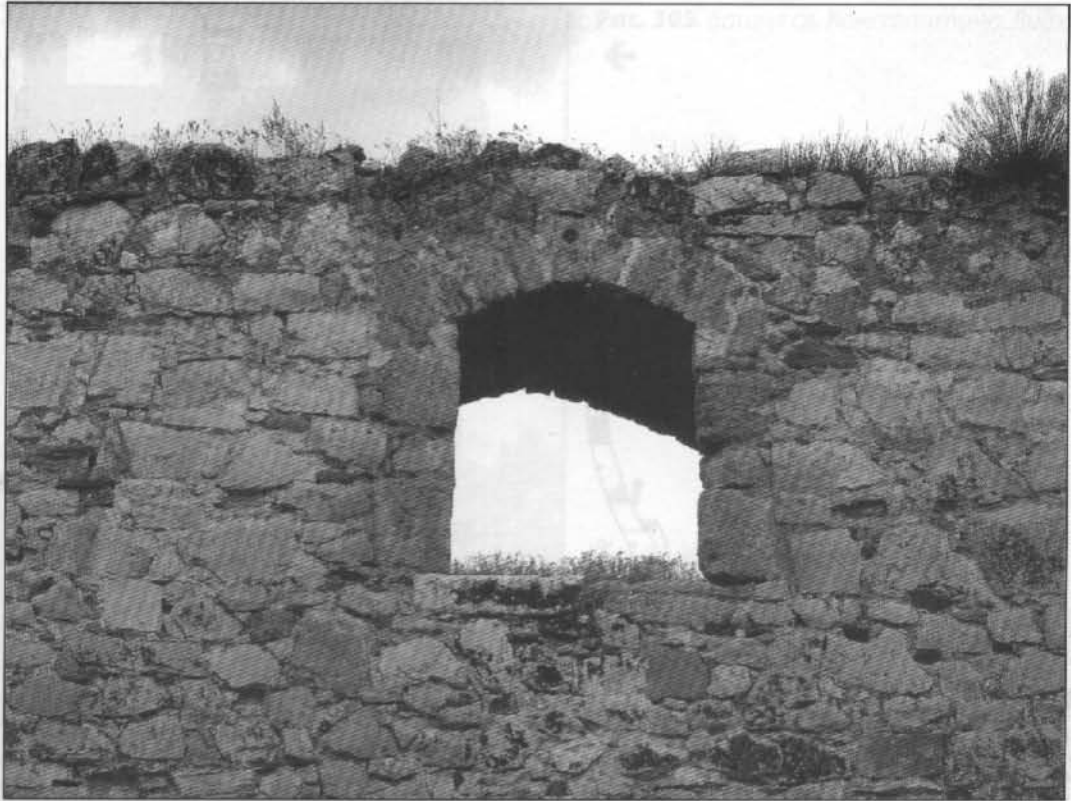
Рис. 302. Окно в западной стене верхнего яруса Доковой башни. Вид с северо-запада
