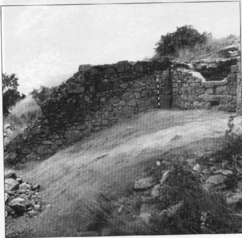
Рис. 138. Угловая башня № 1 и прилегающая к ней стена двора. Вид с севера
