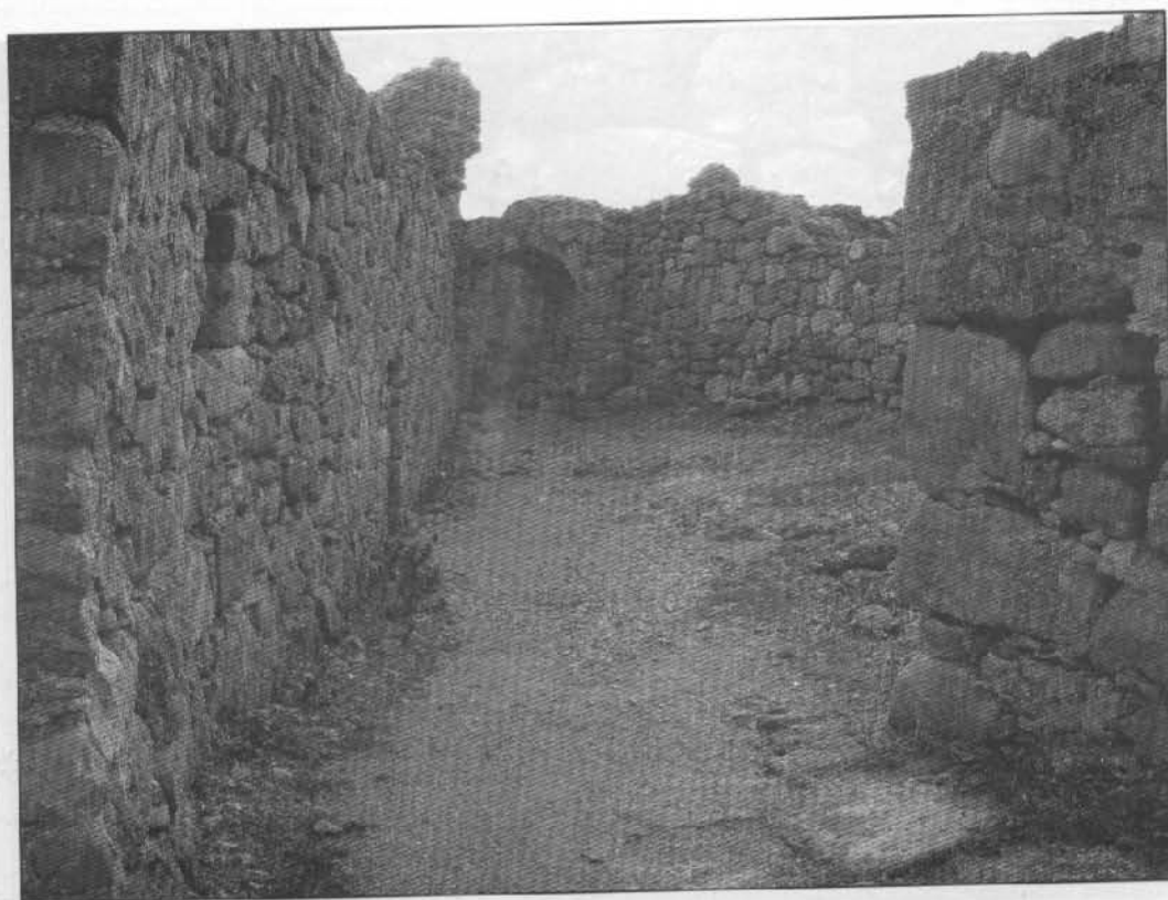
Рис. 242. Дворик между донжоном и церковью. Вид с северо-востока и со стороны входа
