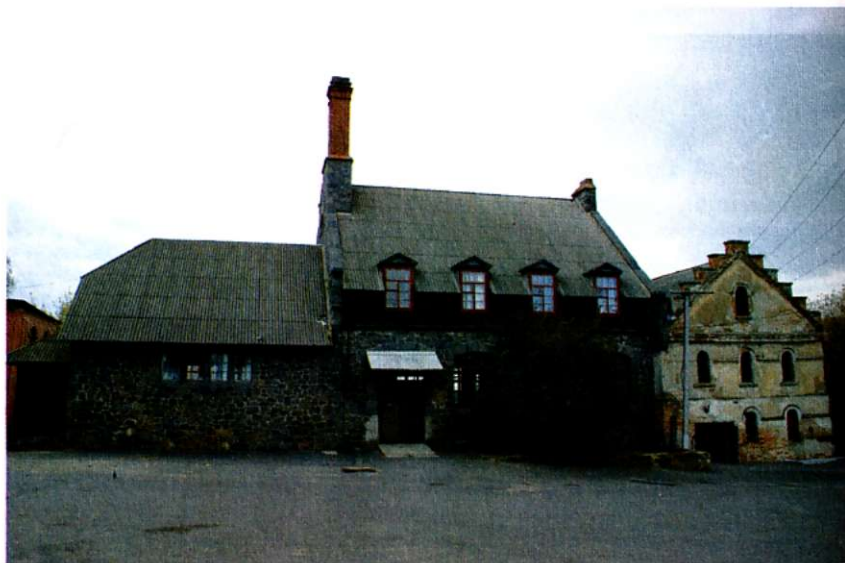
Електростанція і млин (будова-комплекс), 1838–1840 рр., 1909 р., арх. Ф. І. Мехович, м. Немирів
