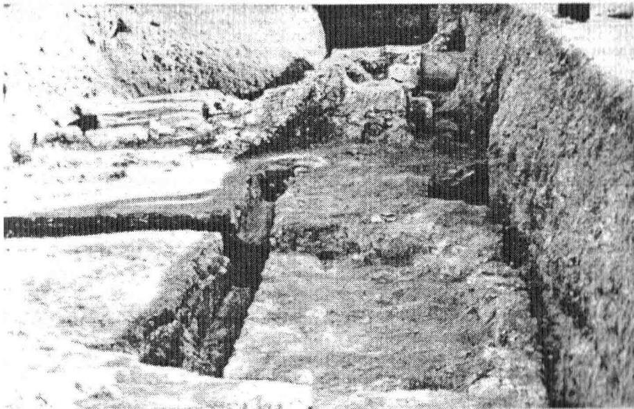
Рис.30. Фундаменти східної стіни Успенського собору старого Галича з прилеглою середущою апсидою, фот. від півночі.
