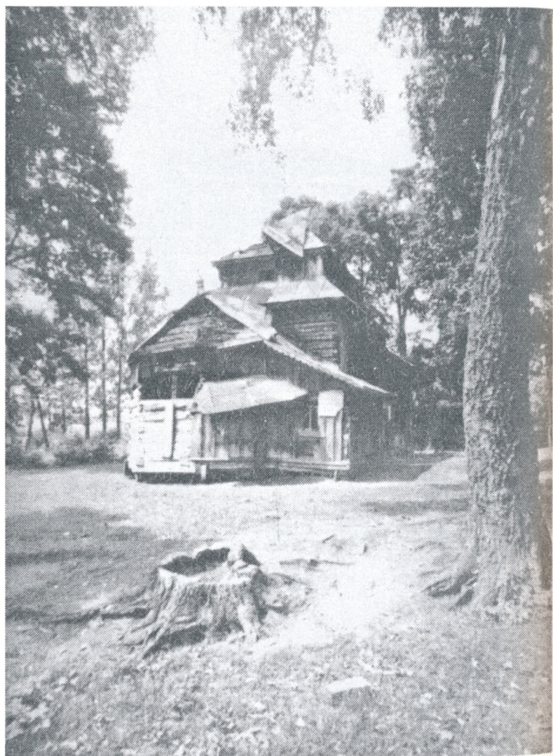
Церква св. Миколая. Лукавець (1701). На світлині церква по пожежі відразу після реконструкції
