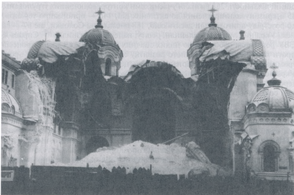
Зруйнована Михайлівська церква у Харкові.
