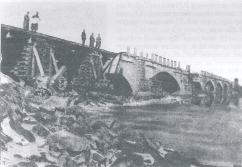
Зруйнований залізничний міст через Сиваш. Крим, 1920 р.
